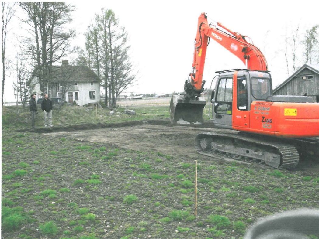
Kuva 2. Kaivinkoneella avattu alue.
