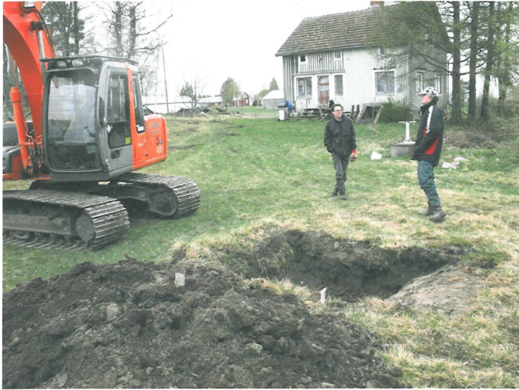
Kuva 3. Pihamaalle kaivettu koekuoppa.
