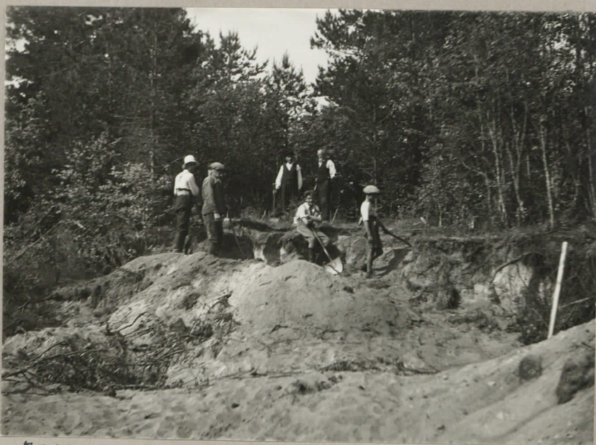
7826 D e , under grävning.
