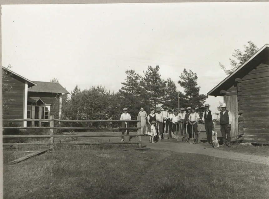
7811 D = Efter utfördt arbete.
