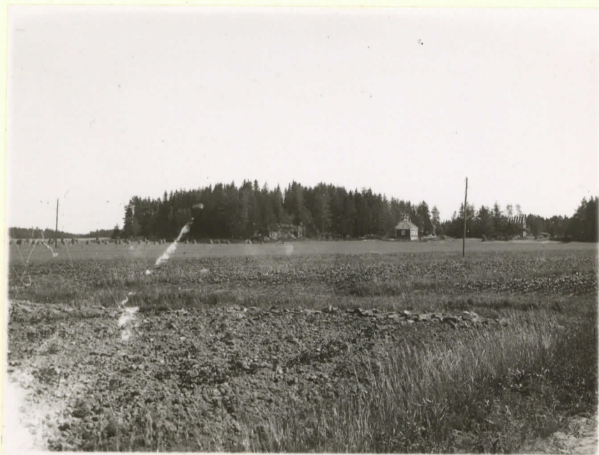
10602. 2. Lieto, Sauvala, Pitkäsmäki, va- lok. maantien puolelta, N:stä. Mäen reunassa Laition sauna ja siitä oikealla rakenteilla oleva Laition uusi päärakennus.
