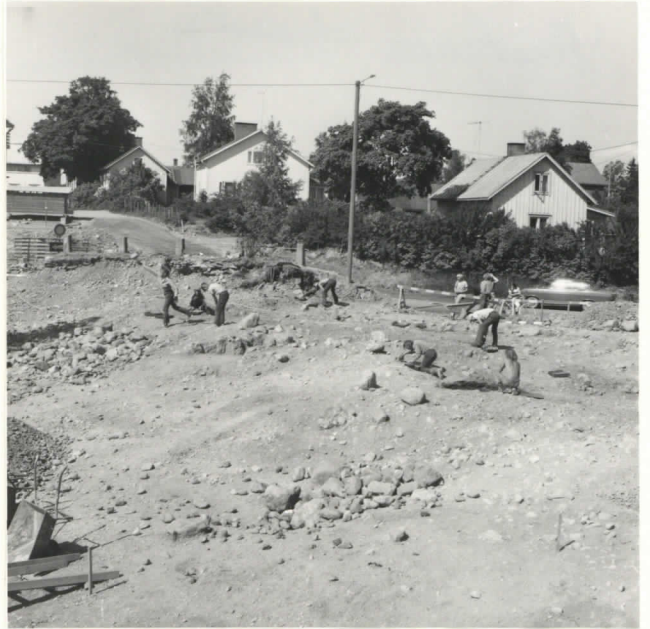
13 YLEISKUVA ALUEESTA KAIVAUKSEN VIIHEISELLÄ VIIKOLLA. KUVATTU ETELÄSTÄ
