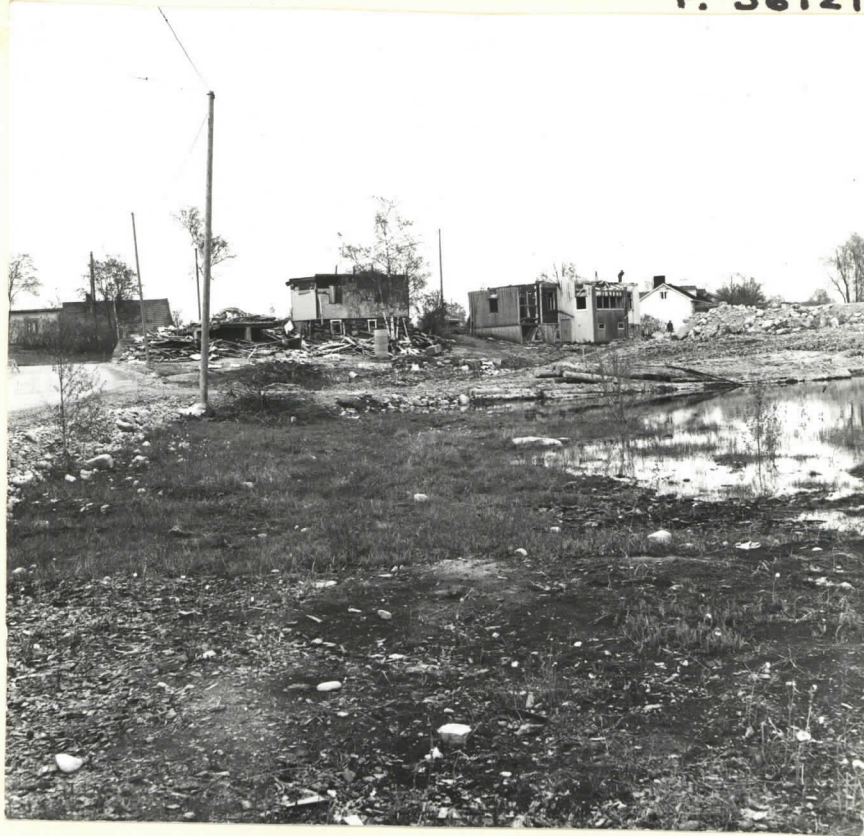
1 ALUE ENNEN KAIVAUSTA 24.5 1971 LÄNNESTÄ PÄIN.
