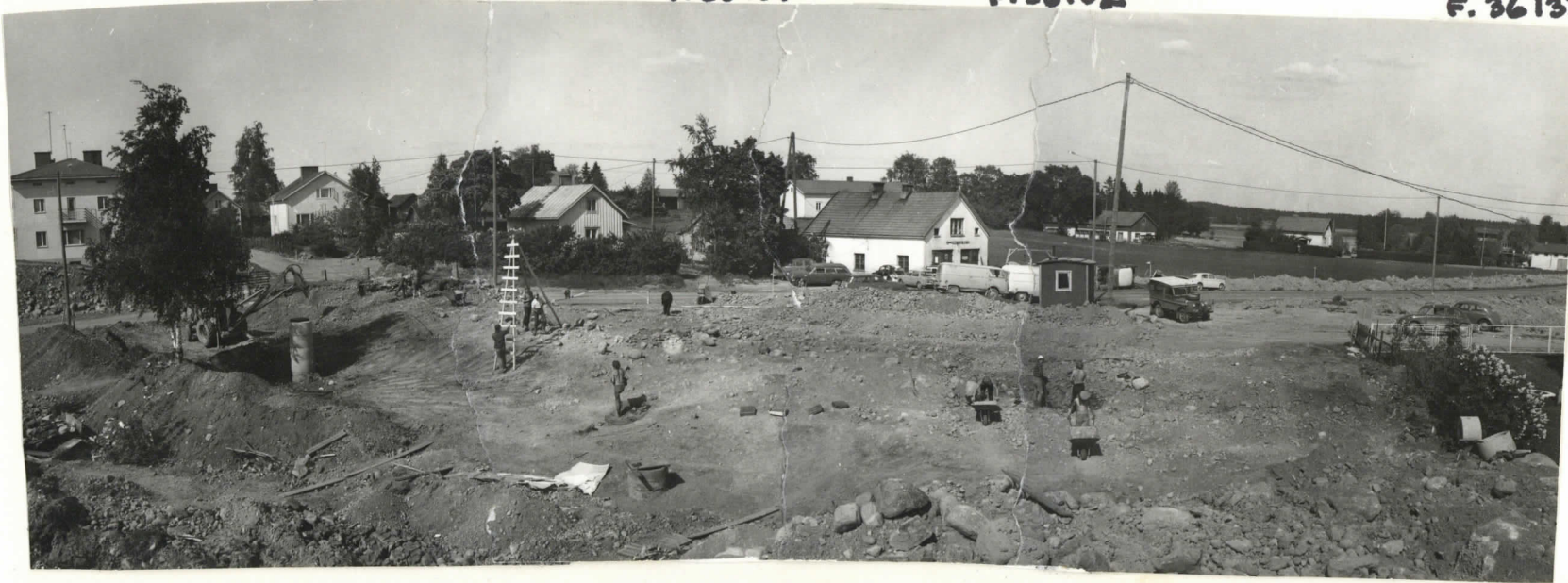
10 PANORAAMAKUVASARJA KAIVAUSALUEESTA KESÄKUUN PUOLIVÄLISSÄ.
