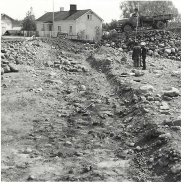
12 KAIVAUSALUEEN ITÄOSA KUVATTUNA LUOTEESTA. TILANNE KESÄKUUN VIIHEISELLÄ VIIKOLLA. F. 36140
