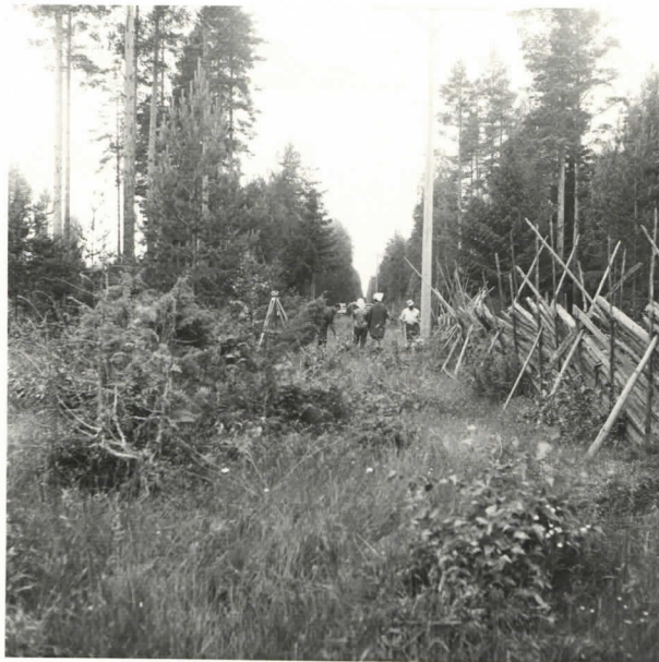
Kuva 10. Kaivausalue paalutetaan Voutilaisen puolella raja-aitaa. Kuvattu kaakosta käsin. F. 33498
