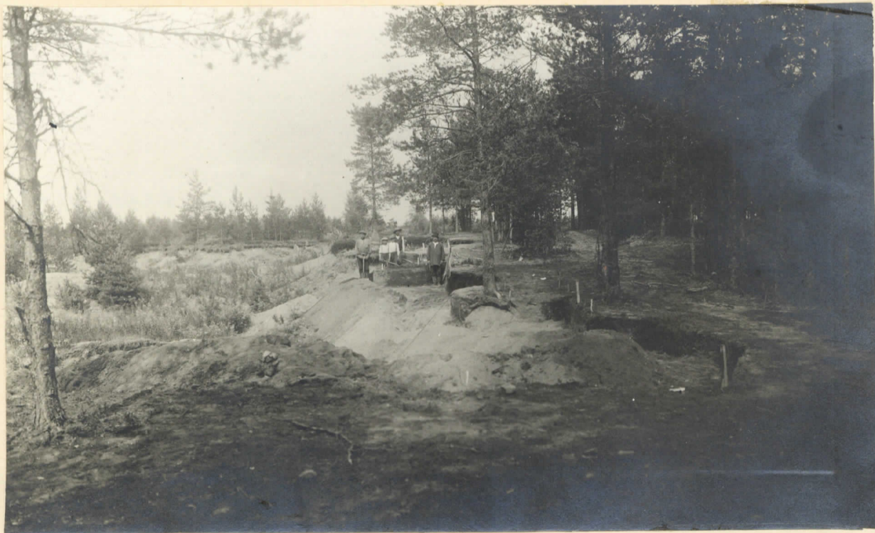
4. Kaivausalue lokakuussa 1915 etelälounaasta katsottuna (Kuviteija P-2: XVIII - XXI kaivetaan parhaallaan).
