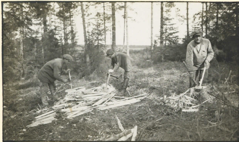
1. Työmiehet veistävät puutupaaluja.
