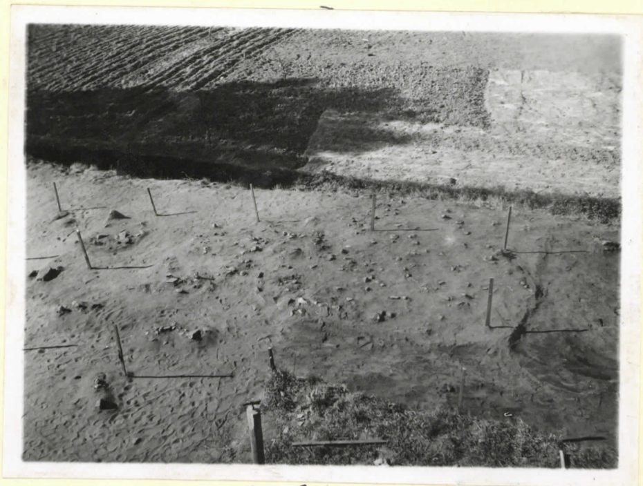
Yokelan alue. Rakennuksen perustukset.
