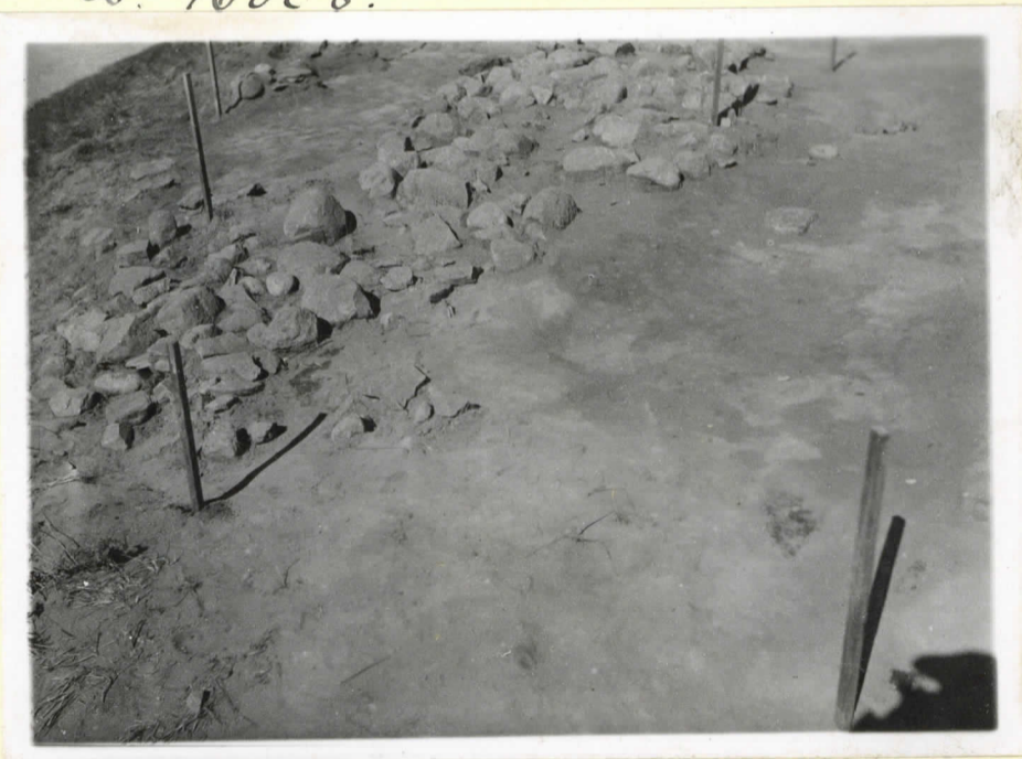
Rautatiealue. Rakennuksen kivetyksen jatkoa (v. n. 1950 kairauksesta.)
