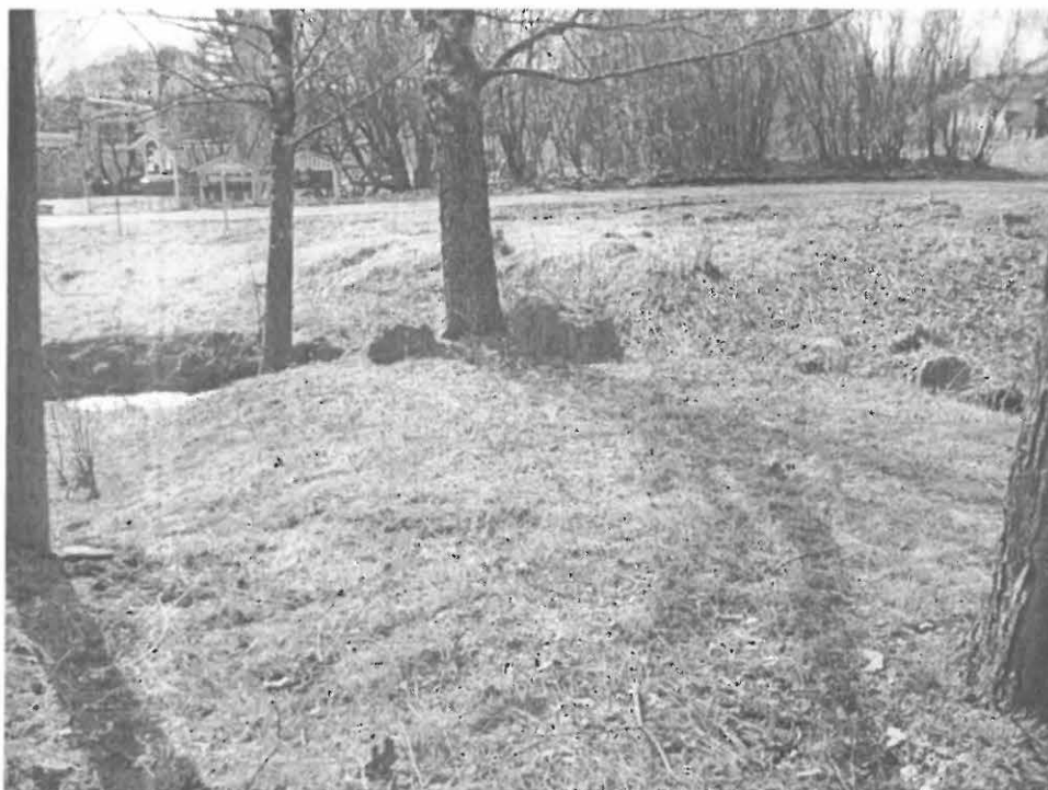
Kuva 7. Tierakenteen säilyneet osat ja kaivannossa näkyvä rakenne samassa kuvassa. Purouoma ei näy kuvassa. DG 117:5.
