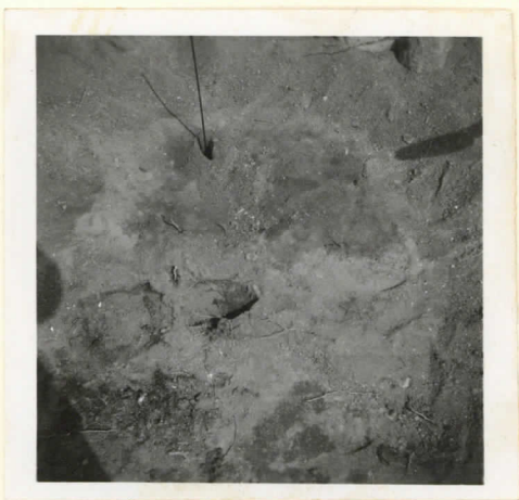
48. Haunta 10, luumualueen pintä. Hauntahuopran muo- to näkyvissä. Paalun pohjalla teräspuikko. (F17149) 88
