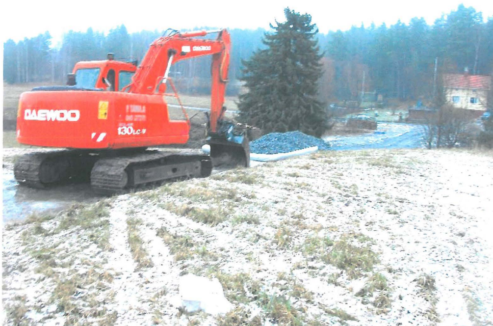
4. Muinaisjäännösalueelta kuvattu kohti pohjoista. Etualalla asuinpaikalle rakennettua tietä. 14.1.2008, Ulla Lähdesmäki.
