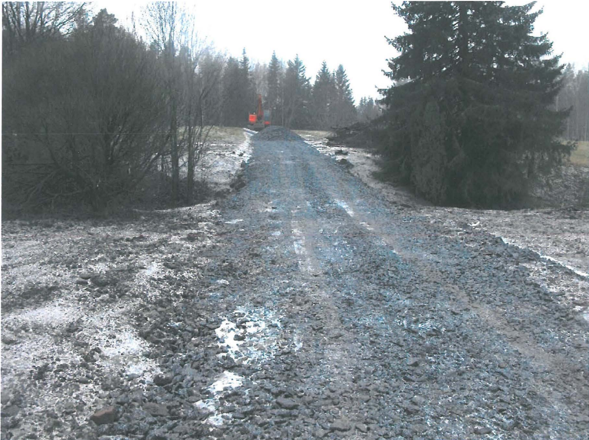
1. Pirkkala, Pirkkalankylä, Juoksianoja 3. Muinaisjäännösalueelle rakennettua tietä, kuvattu lounaaseen 14.1.2008. Muinaisjäännösalue alkaa kuvan taustalla, pellon reunasta. Kuva Ulla Lähdesmäki.
