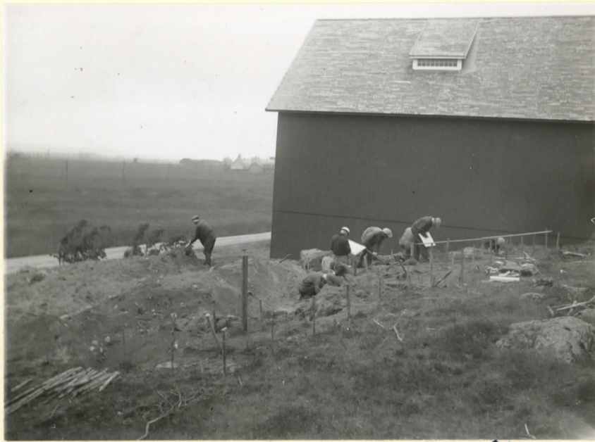
14. Kaivaukset loppumassa, 9490. run- nut 12-13.
