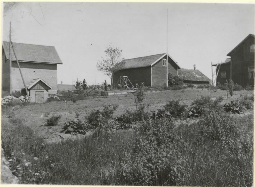
Paimio, Askola, Alitalo. Kaivausalue vasemmanpuoleisen ja keskim. rakennuksen välillä. Kuva P:stä päin. Levy 9520
