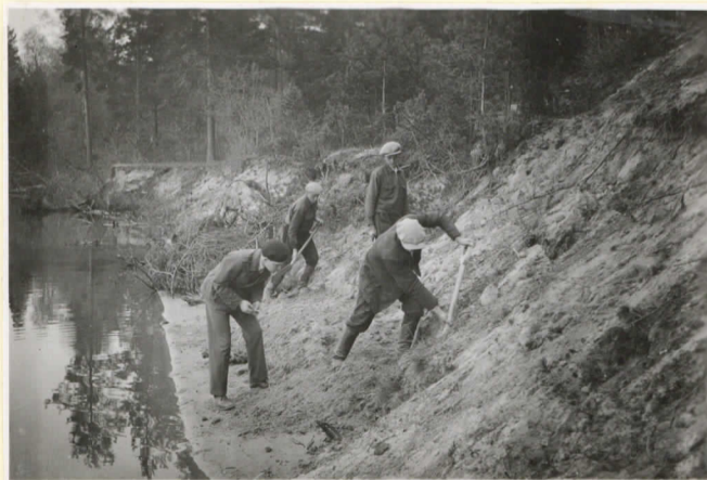
6. I:n kaivauksen alku koillis- esta.
