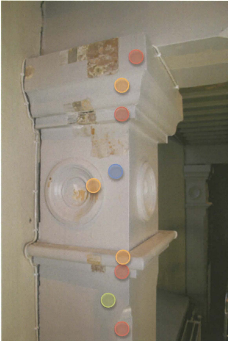
Pilarin alkuperäinen pintakäsittely
