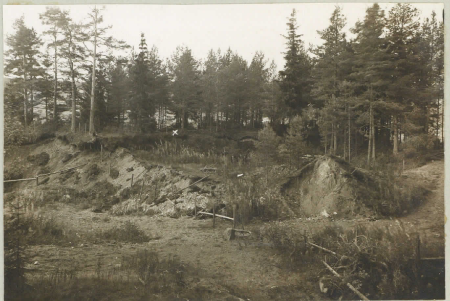
5. Toispuolajannummen tiekkakuoppa edustaan päin. Taustalla: x kairausalue I. 22./9. 1928.
