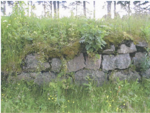
Kasvillisuuden peittämiä muurirakenteita.
