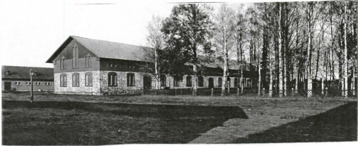
Vuonna 1865 rakennettu navetta, jota sittemmin käytettiin tallina. Osa rakennuksesta muutettiin jälleen navetaksi 1920-luvulla takana olleen navetan purkamisen jälkeen. A.Ahlström Oy Keskusarkisto.
