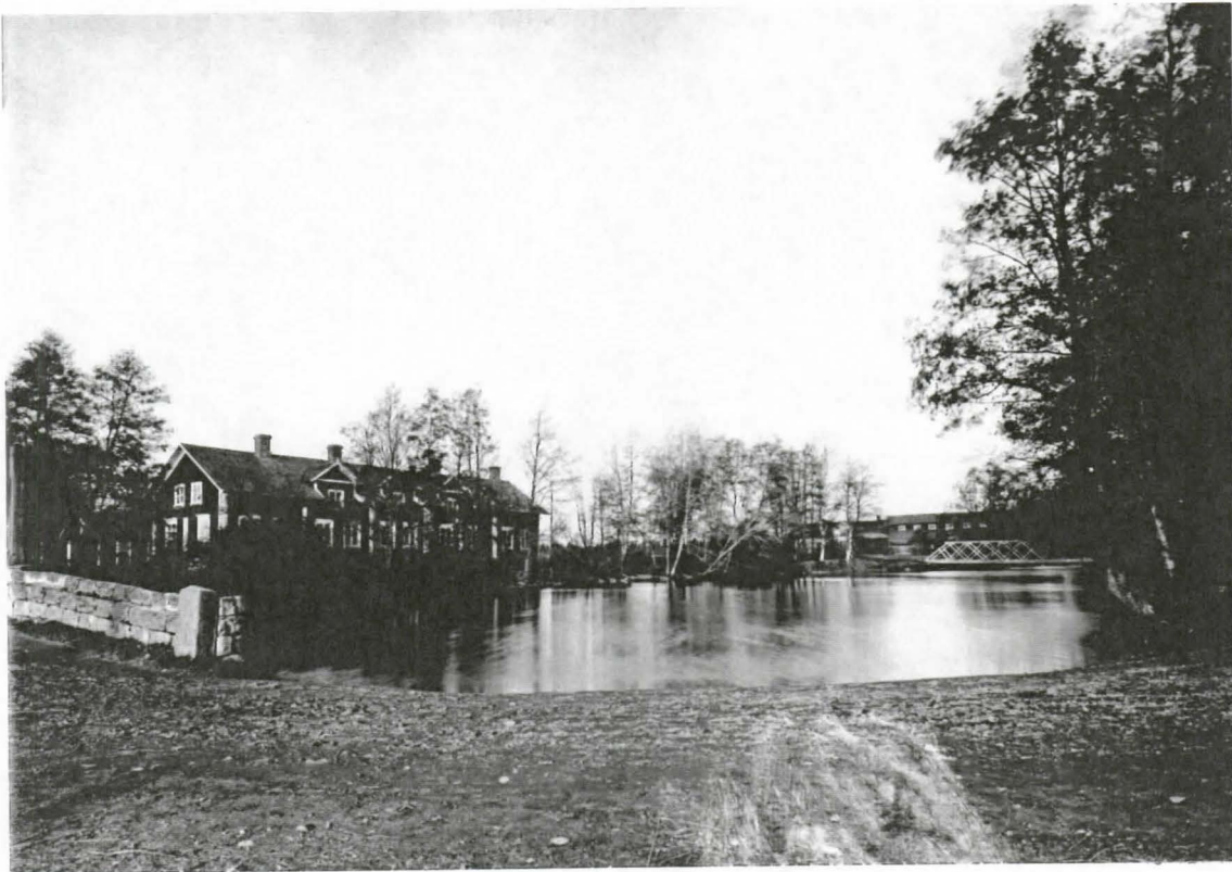
Vanha, vuonna 1795 valmistunut ruukinkartano muutettiin pehtorin ja kirjanpitäjän asunnoksi ja konttoriksi 1860-luvulla. Talo palo 1915. A.Ahlström Oy Keskusarkisto
