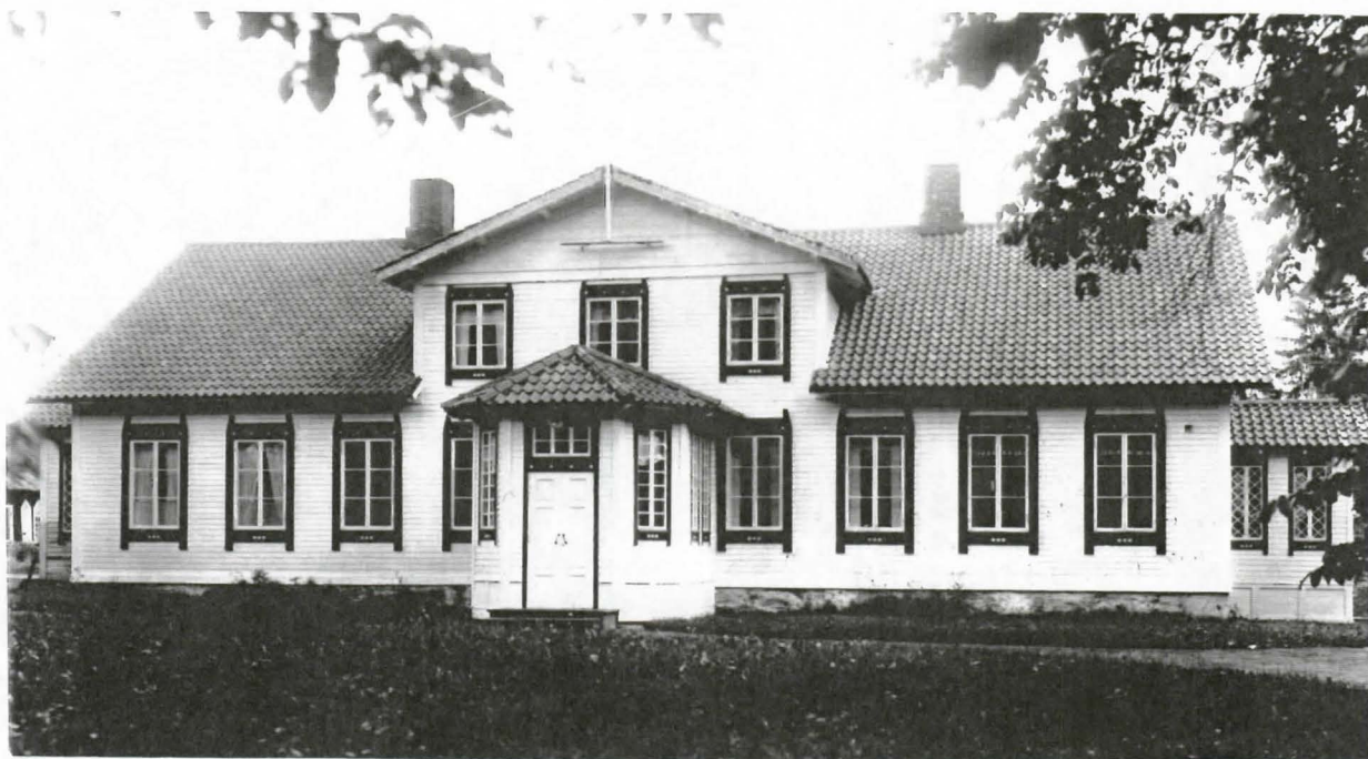
Ruukinkartanon ikkunan vuorilaudat, kuisti ja väritys uusittiin vuonna 1907. 1927 rakennukseen laitettiin savitiilikatto. A.Ahlström Oy Keskusarkisto.
