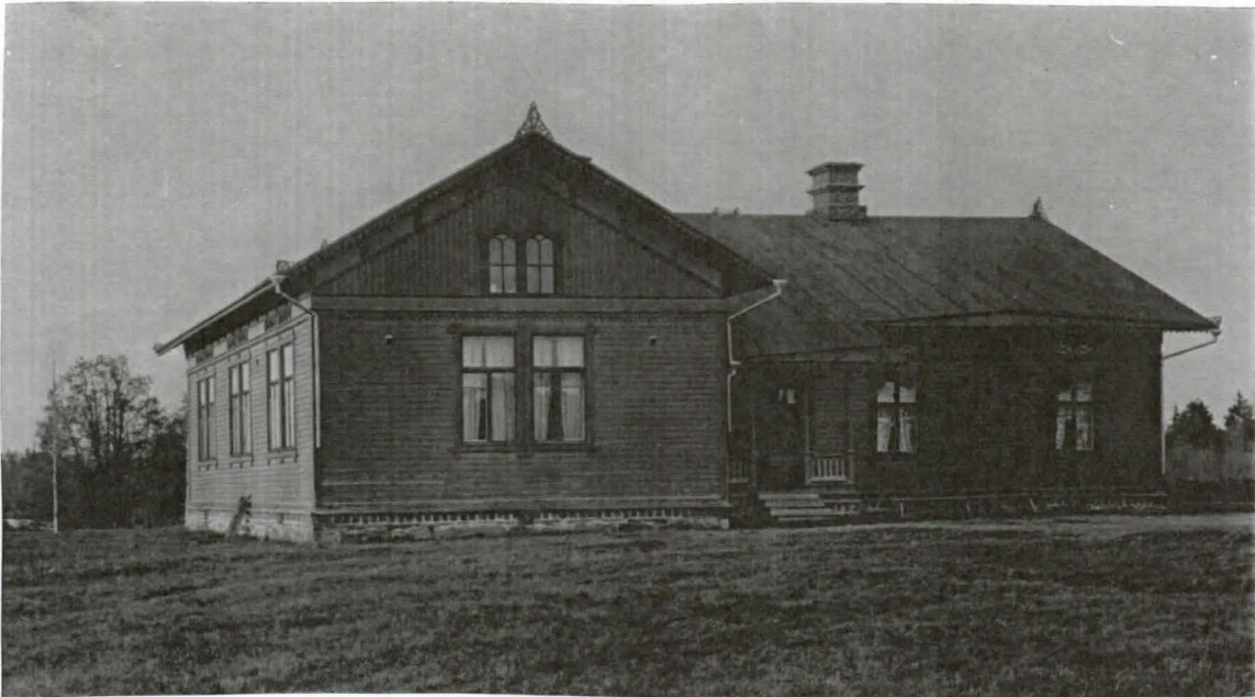
Ruukin Leineperiin rakennuttama, vuonna 1888 valmistunut kansakoulu vuosisadan vaihteessa. A.Ahlström Oy Keskusarkisto.
