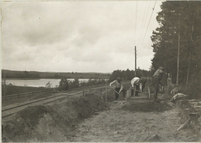
6. II kaivaus kaakosta. Vasemmalla keskellä rautatien ylikäytävä. Takana Savolanlahti.
