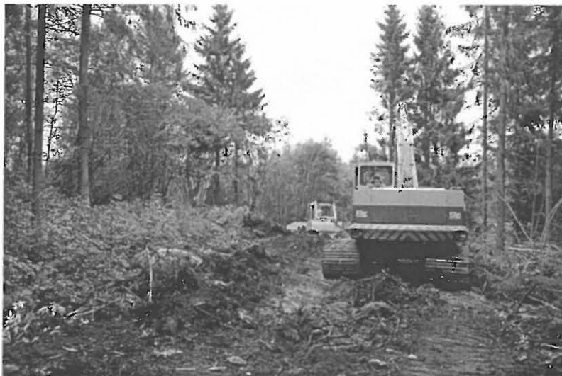
LKM 131840. Uutta tieuraa raivataan. Kuvattu etelästä.
