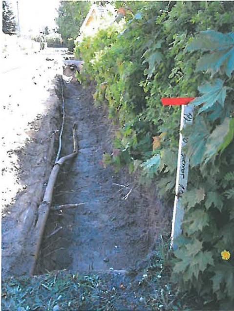
Kuva 4. Valvonta-alueen pohjoisosa kaivettuna. Kuvattu pohjoisluoteesta. Raportin digitaalikuva 006. Kuvaaja: Reetta Kivistö.
