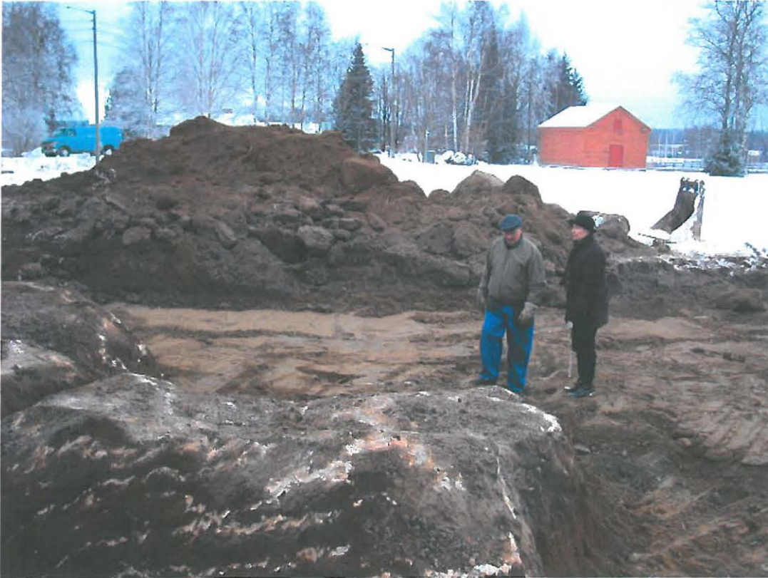
Rakennuksen perustusten kaivaminen, esillä pohjataso, josta tuli esille kalliota. Vas. Reijo Lahtomäki ja Tuula Heikkurinen-Montell. Kuvattu etelästä.
