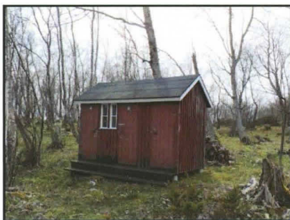
Ulkokäymälä ja varasto
