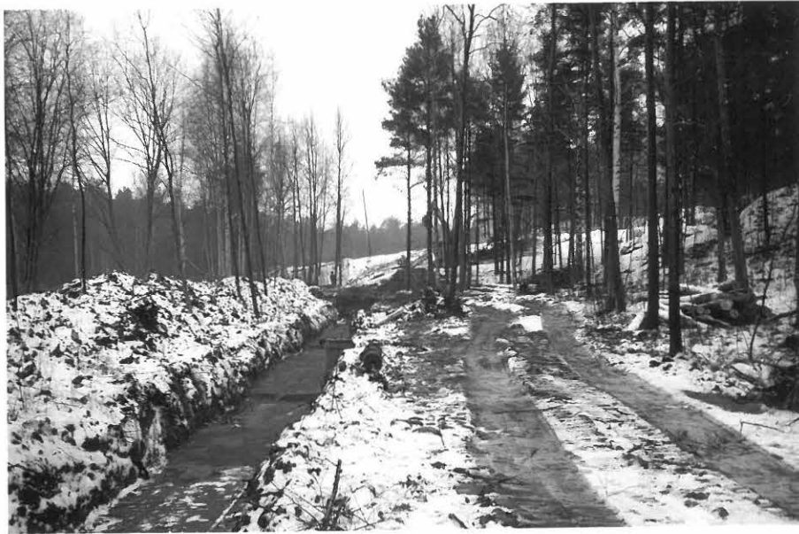
119384 Ojaa täytetty hiekalla ja jatkettu suojealueen pohj. puolelle, etelästä.
