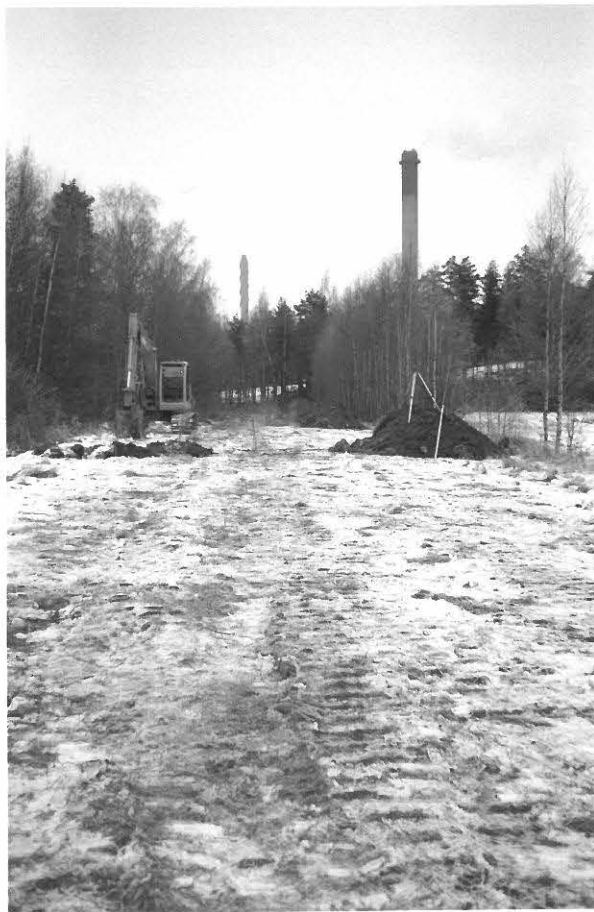
119378 Kaivauksen valvontaa ojassa 4, Lounaasta.
