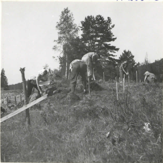
Kuva 5. Käivänsäkeen paaletus Läynnissä.
