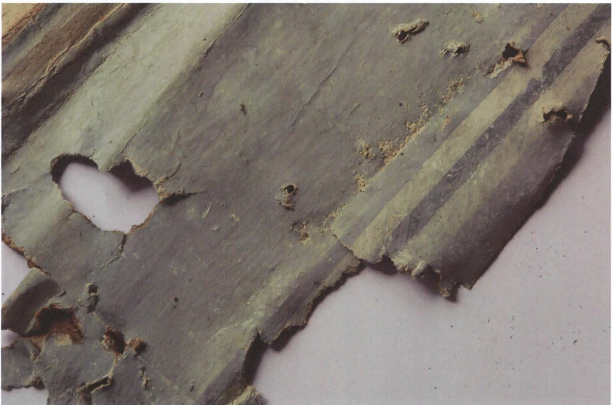
Lännenpuoleisesta seinästä löytyi läheltä katon rajaa tilkkeenä käytettyä kustavilaista, vihertävää "kenttätapettia". Tapettia oli tuotu tilkkeeksi ja se oli käännetty nurinpäin.
