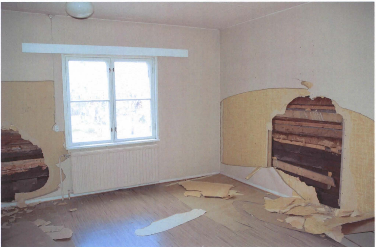
Vinttikamarin oksamassapahviseinää puretaan.
