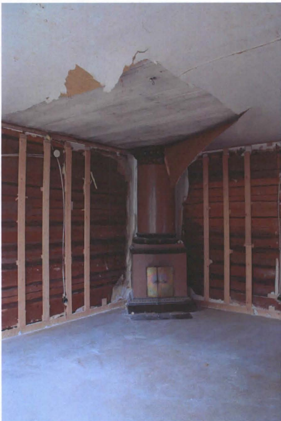
Förmaakin kattoon 1800-luvulla laitettu juuttikangas, josta ei löytynyt maalauskoristeluja. Oikealla olevassa kuvassa näkyy seinään tehty kaappi.
