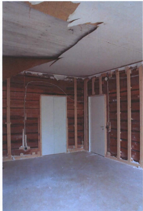
Förmaakin kattoon 1800-luvulla laitettu juuttikangas, josta ei löytynyt maalauskoristeluja. Oikealla olevassa kuvassa näkyy seinään tehty kaappi.
