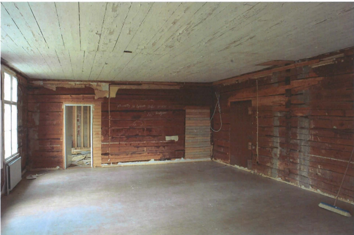
Salin purkutöiden yhteydessä paljastuivat myös alkuperäiset käsikamariin ja tarjoiluvälikköön johtaneet ovet. Kaakeliuuninpaikka näkyy selvästi. Se sijaitsi symmetrisesti "senkin" ja eteiseen johtavan oven välissä.
