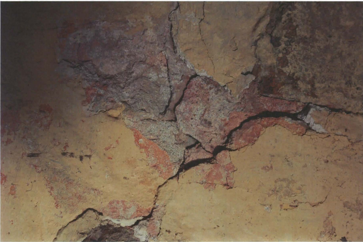
Kivijalassa säilyneitä väripigmentejä eteläpäädyn kuistin alla olevassa varastohuoneessa.
