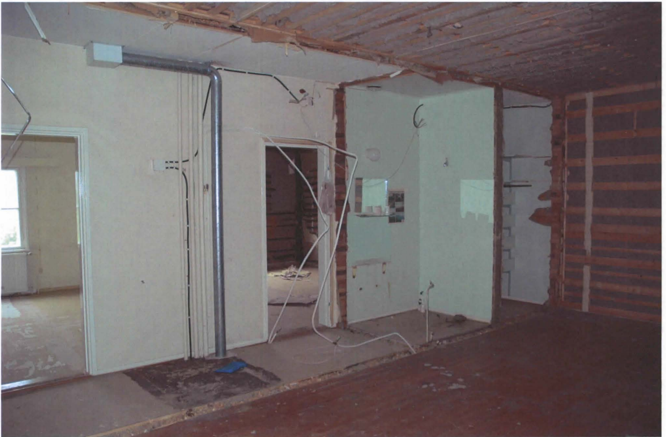
Purettuja rakenteita, keskellä yläaulassa ollut WC.
