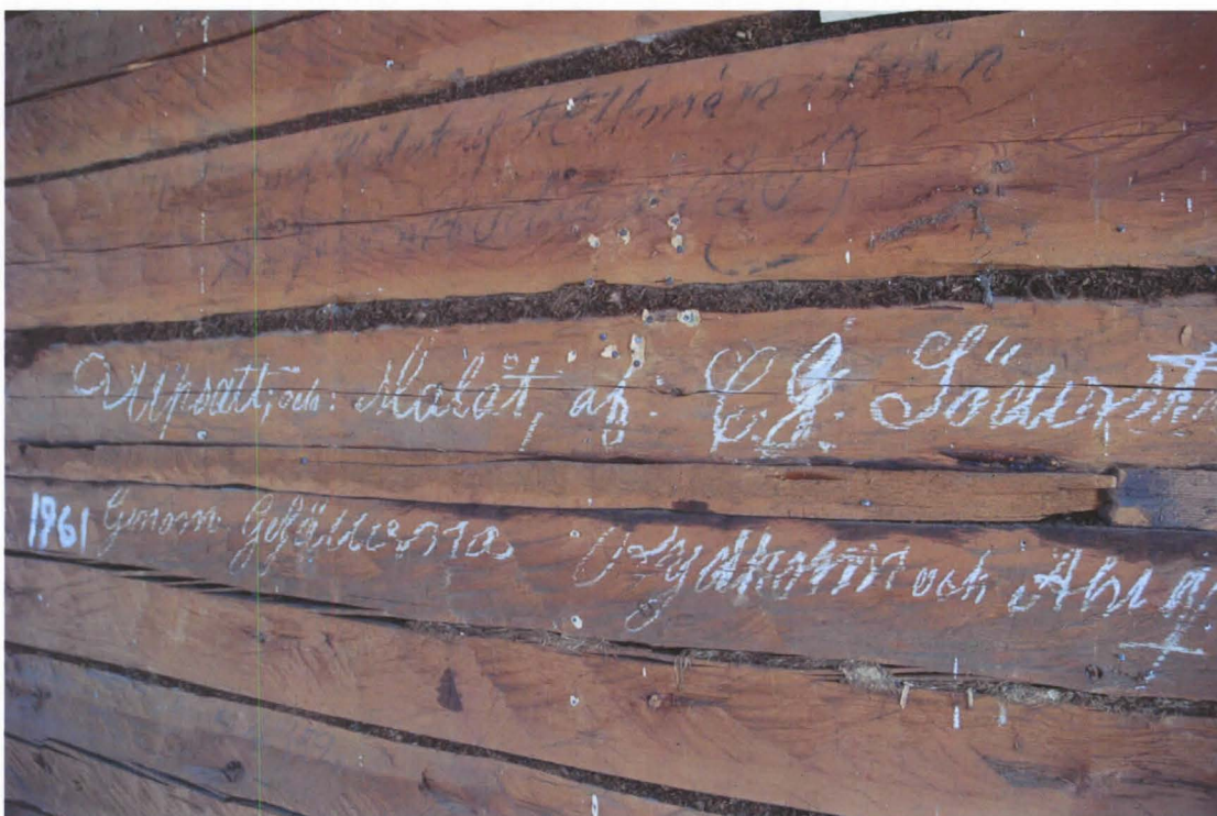
Yläkuvassa vasemmalla näkyvä "pahvaus" sepän takomine nauloineen on todennäköisesti 1843 remontista tai varhaisempi. Myös sänkykamarin oviaukko muutosvaiheineen paljastui. Alakuvassa salin hirsiiin jätettyjä merkintöjä, joista varhaisin on vuodelta 1809.
