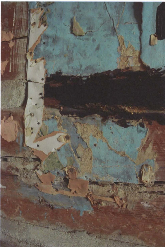
Näkymä kohti yläaulaa. Vaatekomeron ovi on auki, se sijaitsi alkuperäisen tulisijan paikalla. Koteloitu piippu toimii kellarissa sijaitsevan lämpökattilan savuhormina. Alhaalla vasemmalla olevassa kuvassa huoneen vanhimpia tapettikerroksia. Sinisen liimamaalitapetin päällä vaaleanpunaista ja vihreää liimamaalitapettia. Oikealla olevassa kuvassa 1890-luvun ja 1900-luvun alun tapetointivaiheita.
