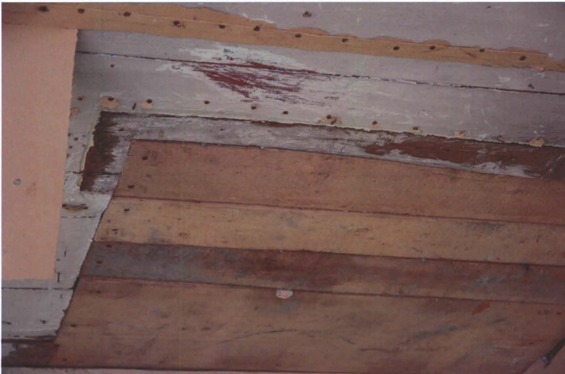
Purkutöiden yhteydessä paljastui vanha leveämpi oviaukko ja oikealla yllä näkyvässä kuvassa kulmakarin alkuperäinen oviaukko. Katto on maalattu alkuaan punamullan värisellä maalilla. Tämän päällä oli ainakin kaksi valkeaa liimamaalikerrosta.
