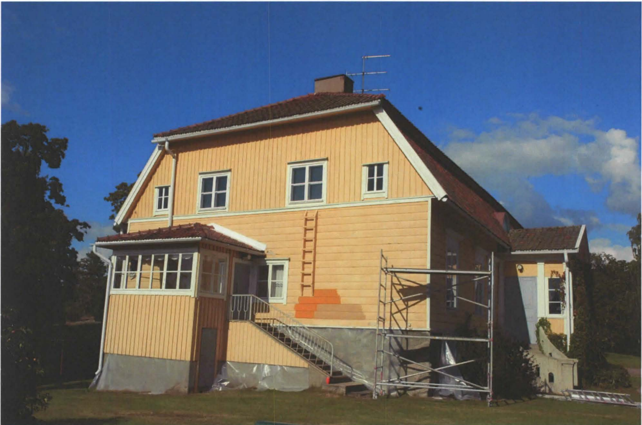
Maalisävykokeiluja kesällä 2007 eteläpäädyssä.
