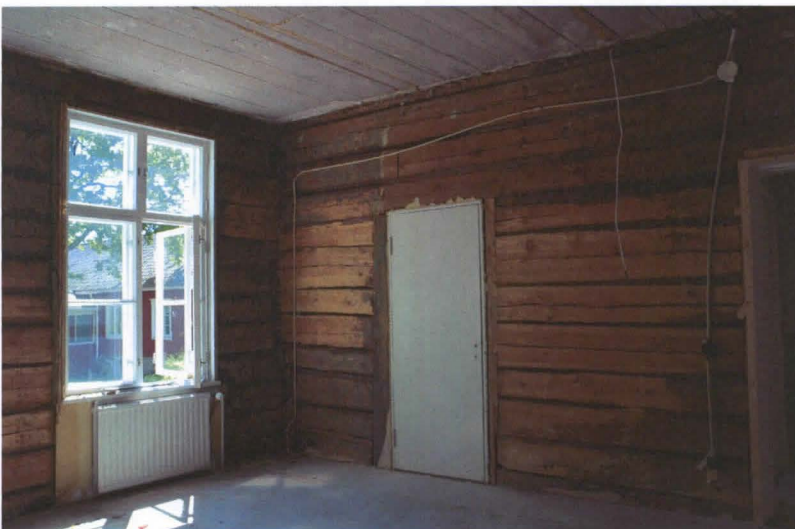
Lastenkamariin johtanut vanha oviaukko tuli esiin rakenteita purettaessa.
