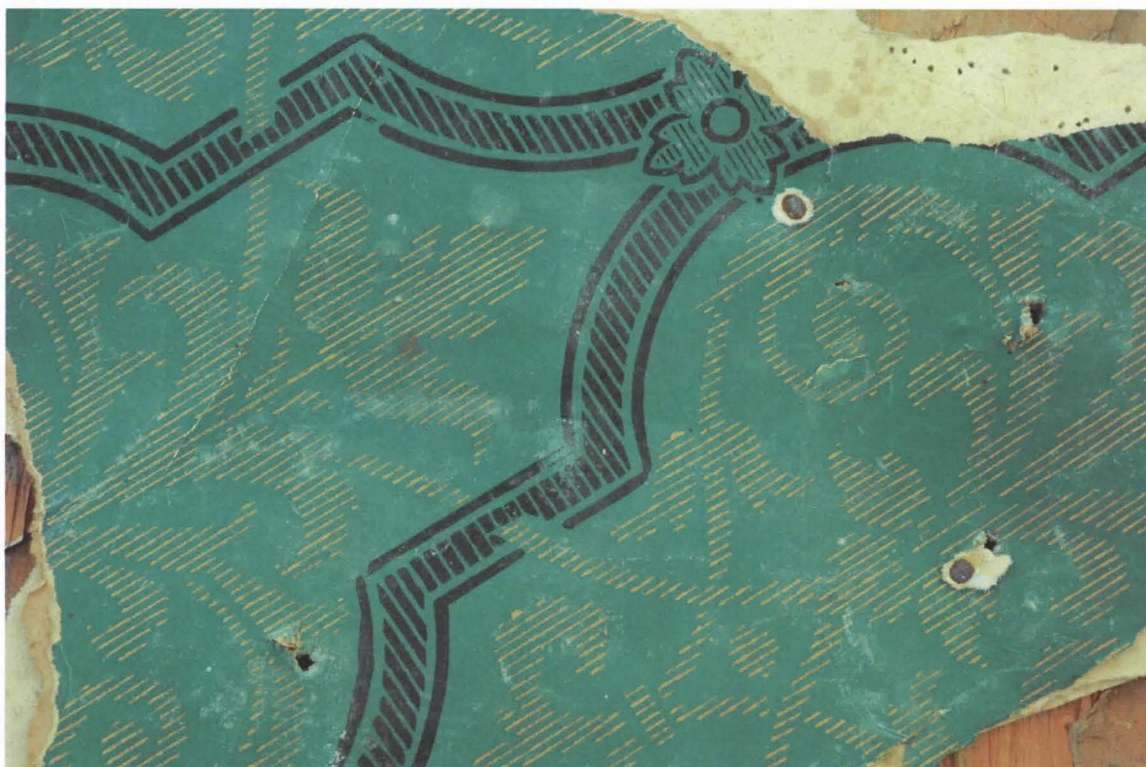
Pinkopahvituksen päälle kiinnitetty 1870–80 -lukujen tapetti.
