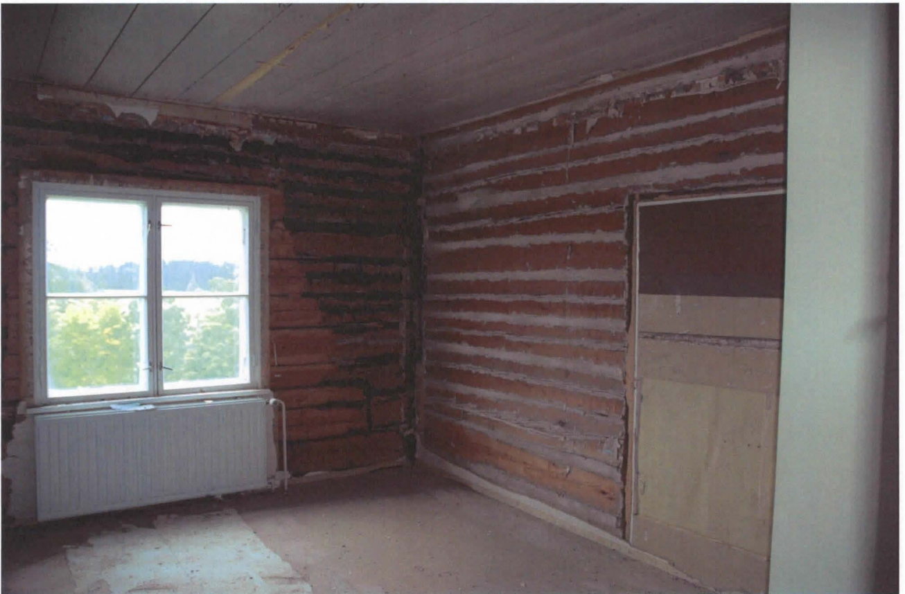
Rakenteita purettaessa paljastui väliovi, joka oli tehty kamareiden välille.
