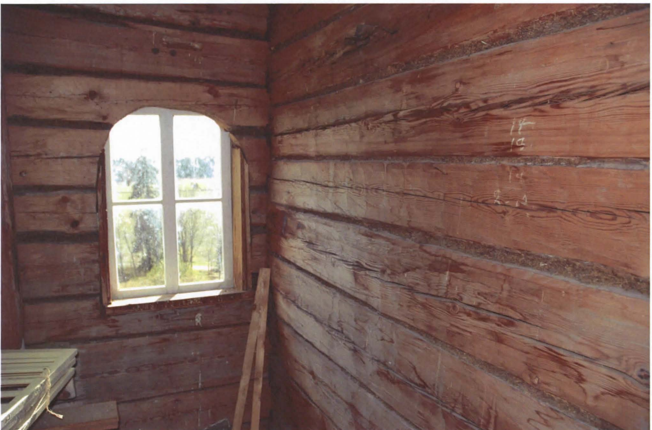
Yläkuvassa vanhoja lunetti-ikkunoita ullakolla. Eteläpäädyn alkuperäiset, soikeat ikkunat on korvattu suorakulmaisilla ikkunoilla.
