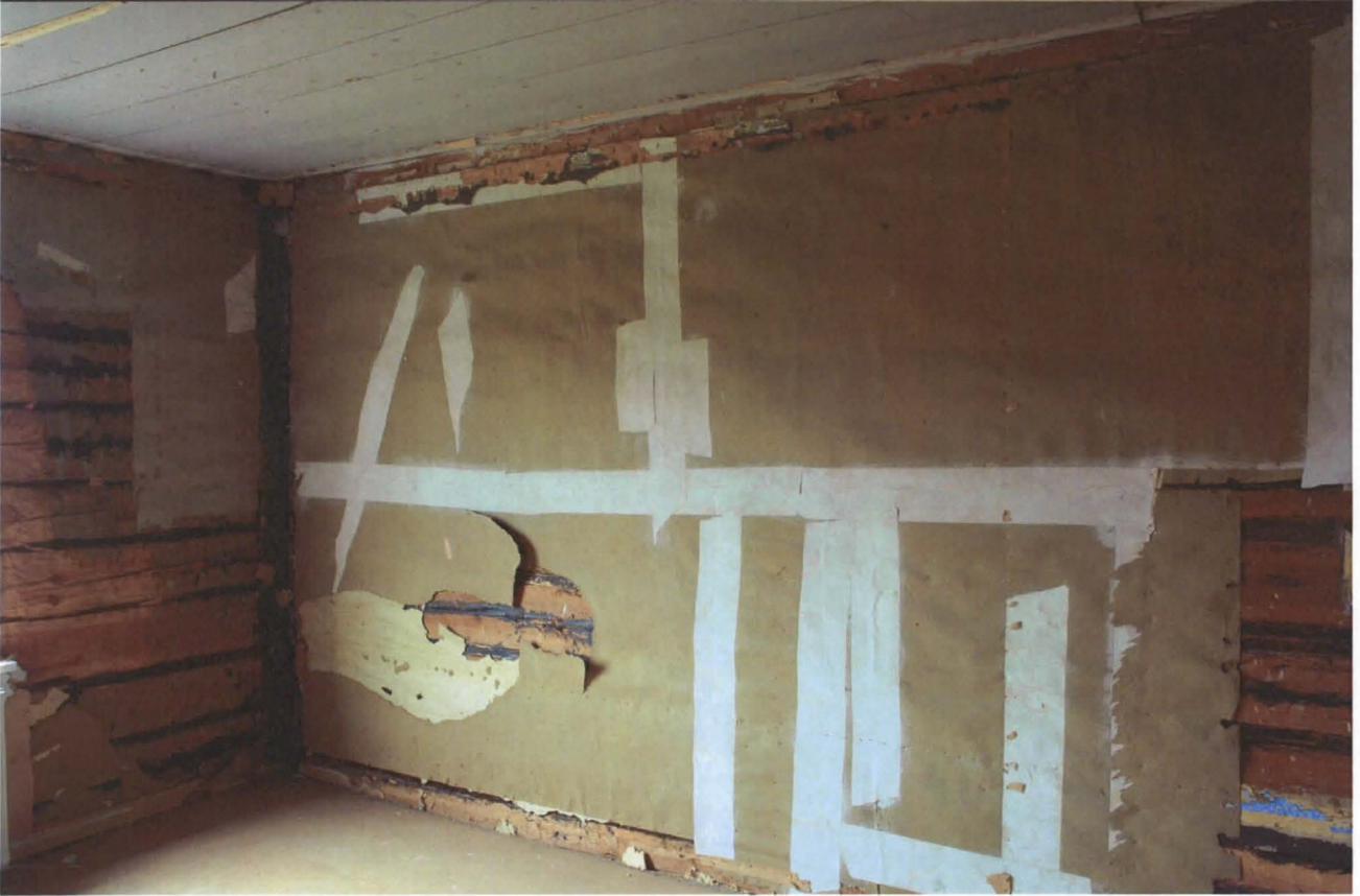
Kamarin yhteydessä on vaatekomero. Alakuvassa näkyy lännenpuoleisesta seinästä paljastunut "pahvaus". Pahvin takaa löytyi runsaasti vanhoja tapetteja, joita oli käytetty tiivisteinä.
