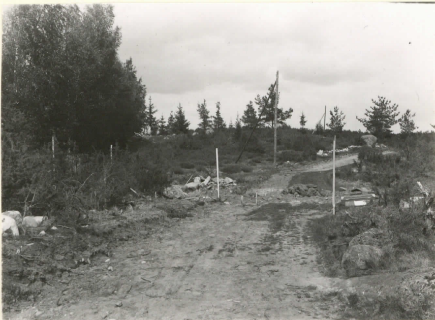
Kuva kaivauspaikalta, S:stä L. 13261 päin. Tienkohta kaivauksen alla.
