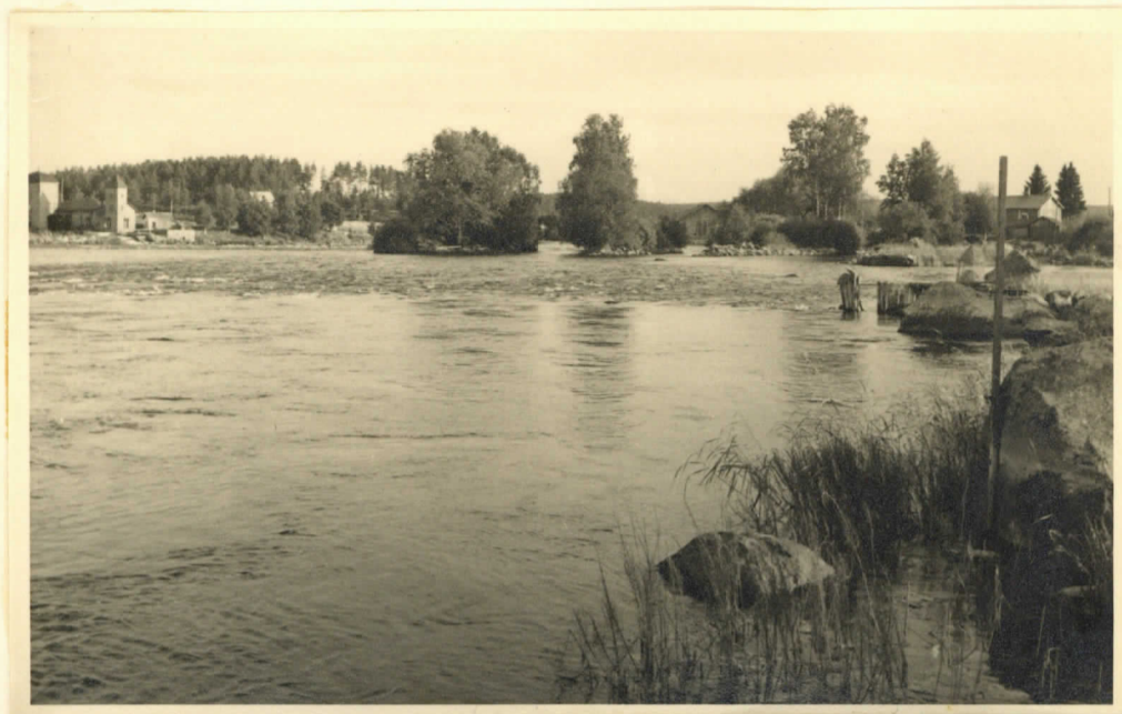
14244. Vasemmalla sähkölaitos Tyrvään kylän puolella, sen takana Heidenmäki, toisella Kinkkoisten koski, pensaitten takana Hartolan koski, josta on yllä. O. K. Mealla Aspin rakennus.
