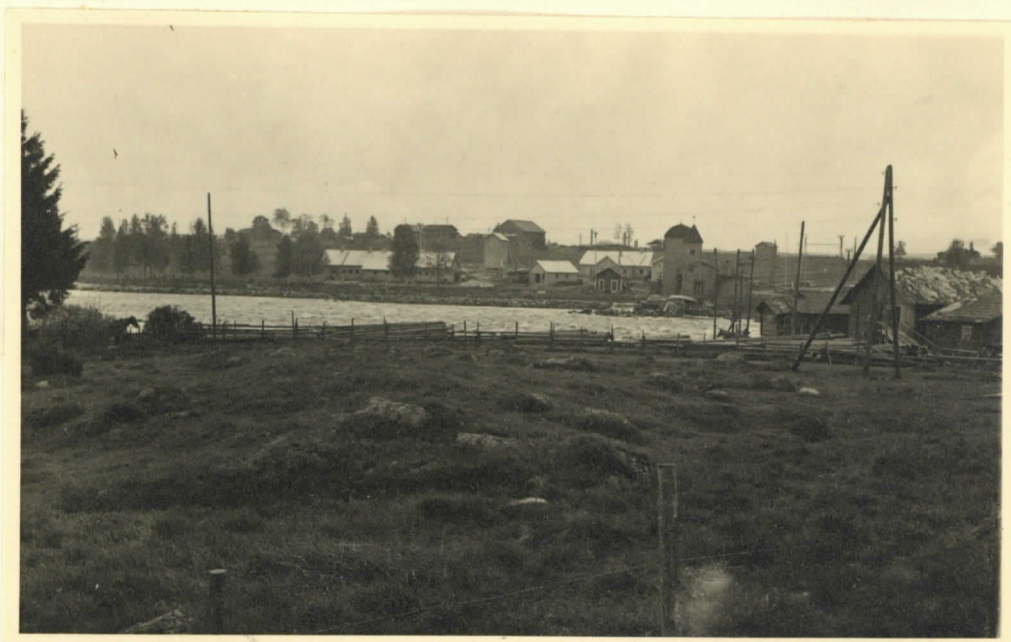
14279. Tyrvää. Kankolan ja Tyrvään kylät. Joen takana Tyrvään Voiman rakennuksia, kauempana Niemen lelu-tehdas ja Toi- von Palo. Tällä rannalla on myyjät ja etu- alalla hautakumpu 110 D.
