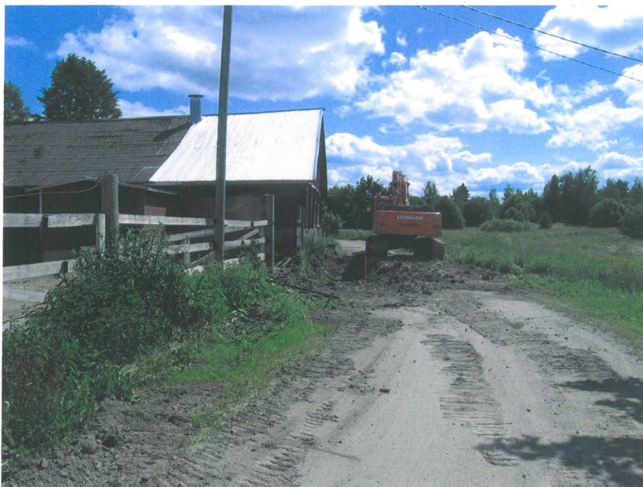
Kuva 1. Yleiskuva kaivannosta työn alkuvaiheessa, kuvattu luoteesta. Kuva Aija Teinonen.
