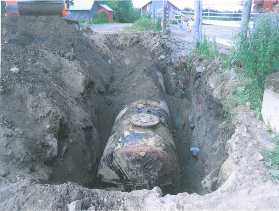
Kuva 5. Säiliö sijoitettuna kaivantoon. Kuva Aija Teinonen.
