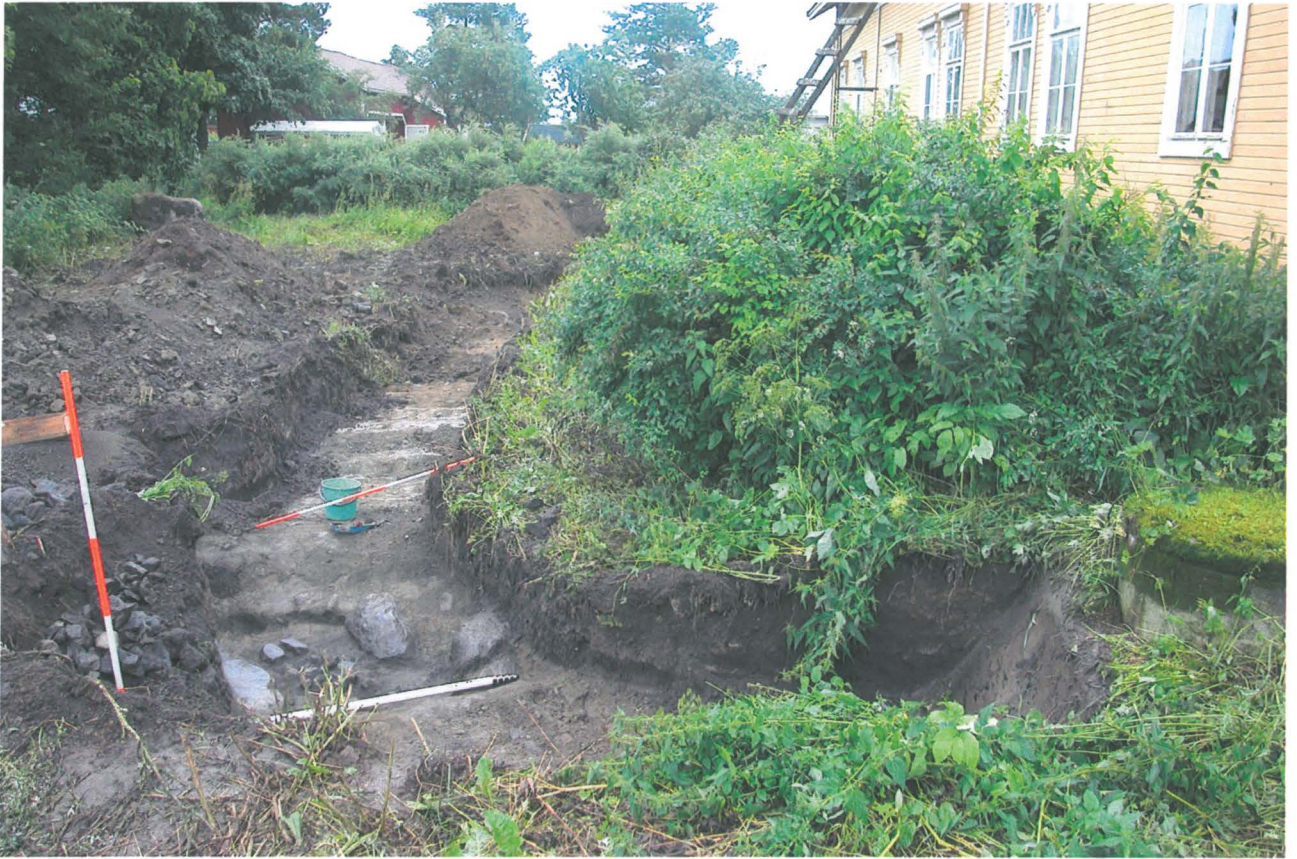
DSCN0144.JPG Kohde 1. Yleiskuva kaivannosta. NW
