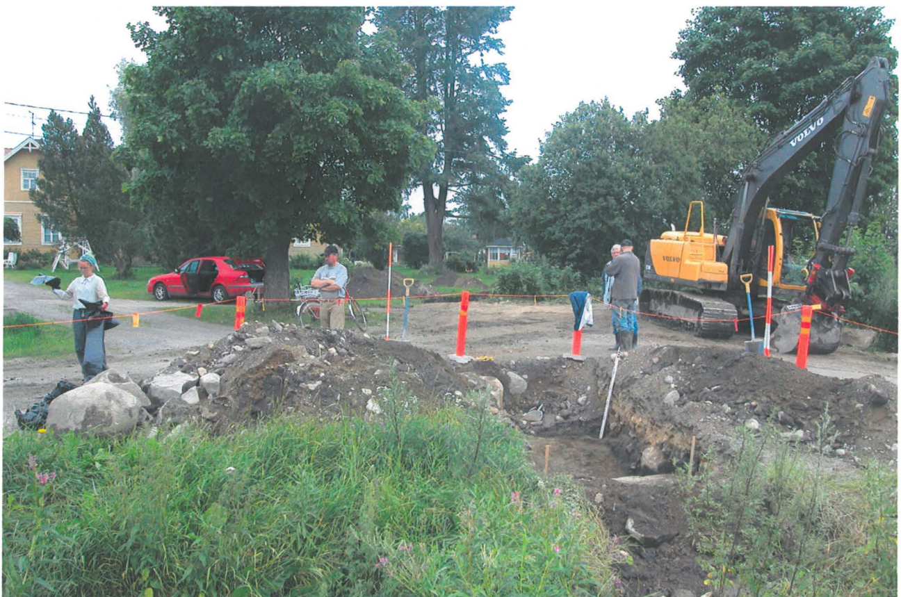
DSCN0179.JPG Risteyksen alue, kohteet 2 (etualalla) ja 3 (taustalla, kaivinkoneen alla, peitettynä). SW
