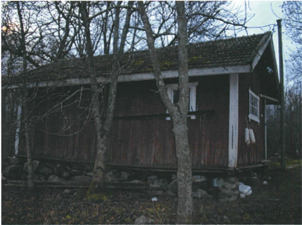
Pappilan nuottavaja rakennus 36 (V2)/ kuva 5
