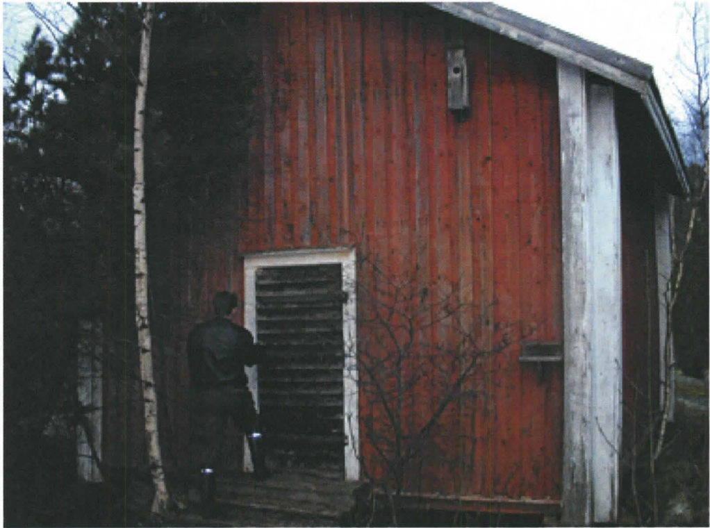
Pappilan aitta rakennus 37/ kuva 3
