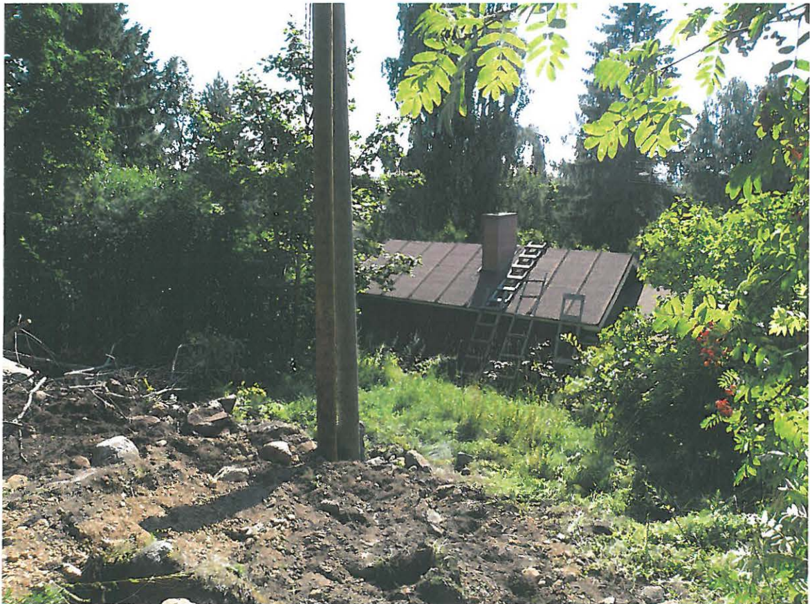
Kuva 1. Sähköpylväs 22 asennettiin edellisen tolpan välittömään läheisyyteen. KY 25:6. Kuvaaja KL.
