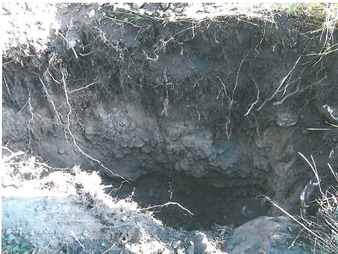
Kuva 2. Koneellisesti kaivettu kuoppa tulevan sähkötolpan numero 20 kohdalla. KYY 25: 3. Kuvaaja KL.
