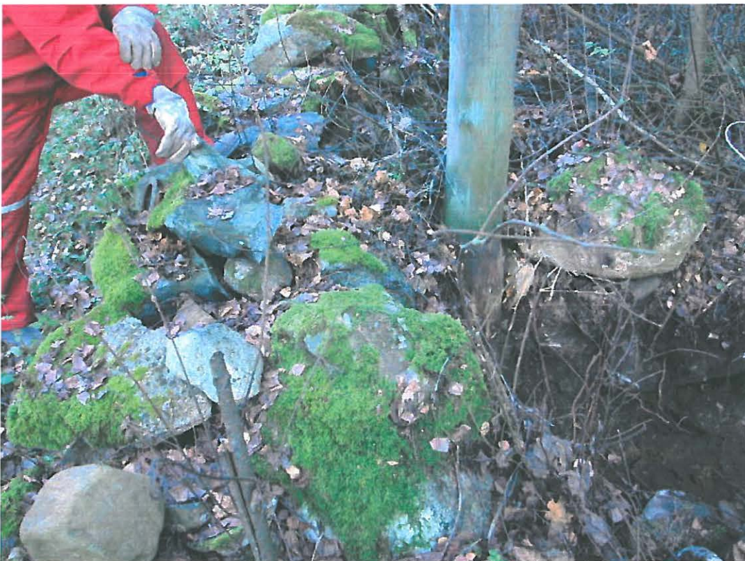
Pylväspaikka 5, vanhan pylvään poistaminen. Pylvään vieressä vanha kivikaita. Kuva Ulla Lähdesmäki.
