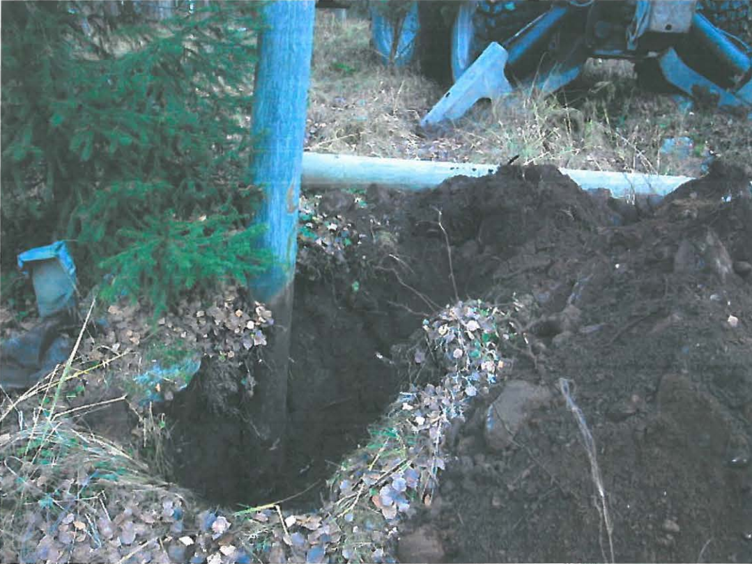
Pylväspaikka 6, vanhaa pylvästä kaivetaan esille. Kuva Ulla Lähdesmäki.
