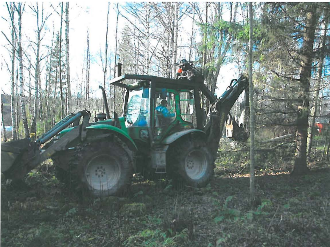
Kaivinkone pylväspaikalla 5. Kuva Ulla Lähdesmäki.
