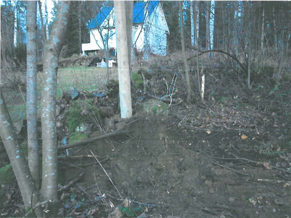
Pylväspaikka 5 uuden pylvään pystytyksen jälkeen, kiviaidan vieressä. Kuva Ulla Lähdesmäki.
