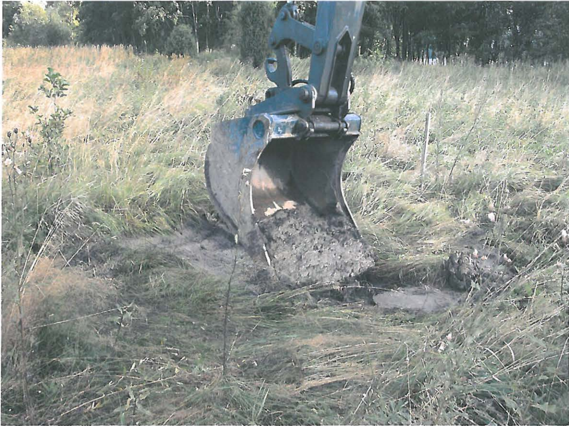
DSCN9665.JPG Sähkölinjan NW-osa. Kaivuutyöt käynnissä.
