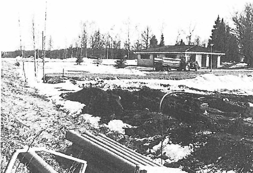
116208 Vesijohtokaivannon SE-osa, linjakeppi tutkitun kuopan kohdalla. Taustalla seurakunnan huoltorakennus. NNW
