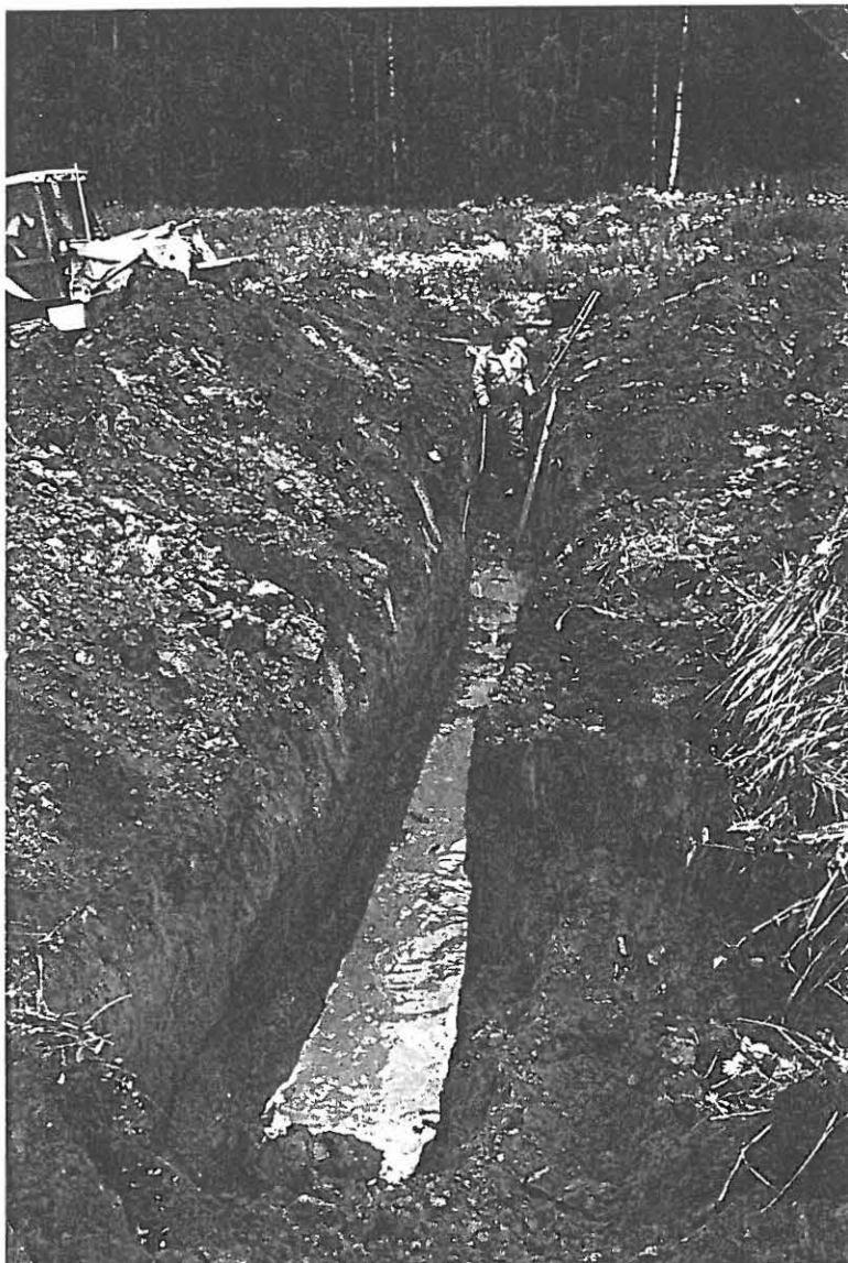
116812 Viemärikaivannon pohjoisosa. SSW
