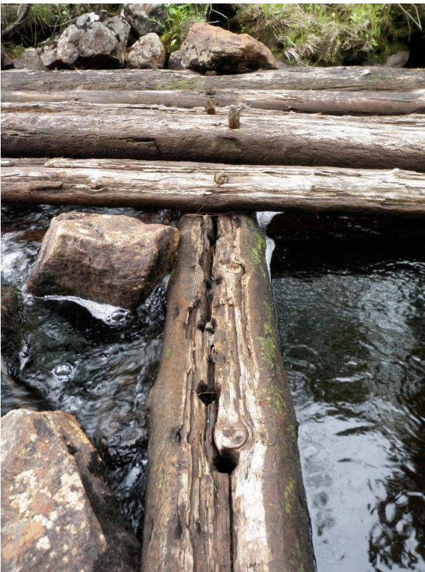
Pahaoja 1 uittotammen puurakenteita ojassa. Kuva: J. Puikko.
