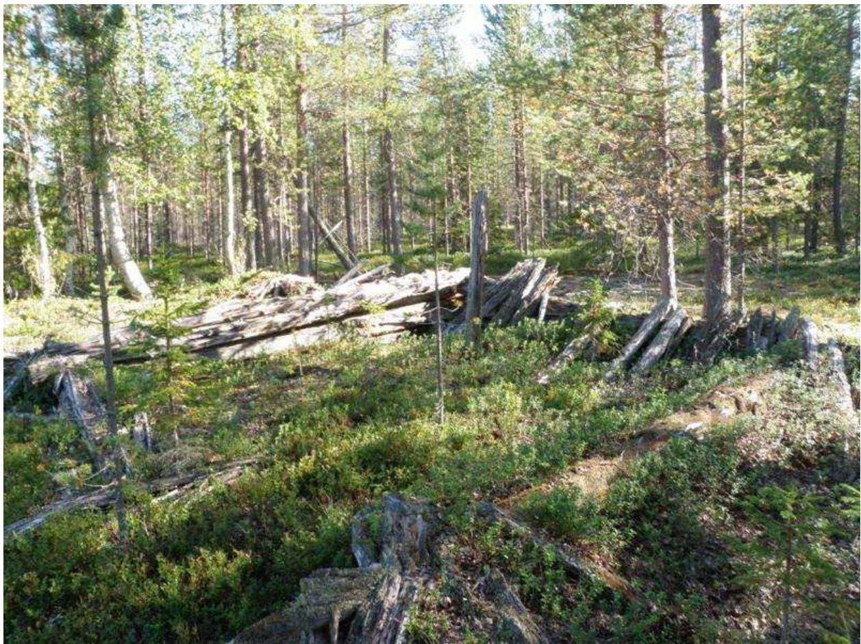
Romahtaneen katon kellesten päät ovat jääneet roikkumaan hirsiseinien päälle.
