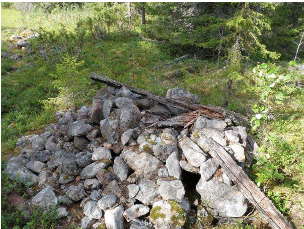
Rakennuksen 2 uunin raunio, jossa on osa holvirakennetta jäljellä.
