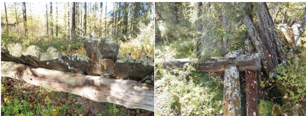
Uittopatoa ja sen tukirakenteita.
