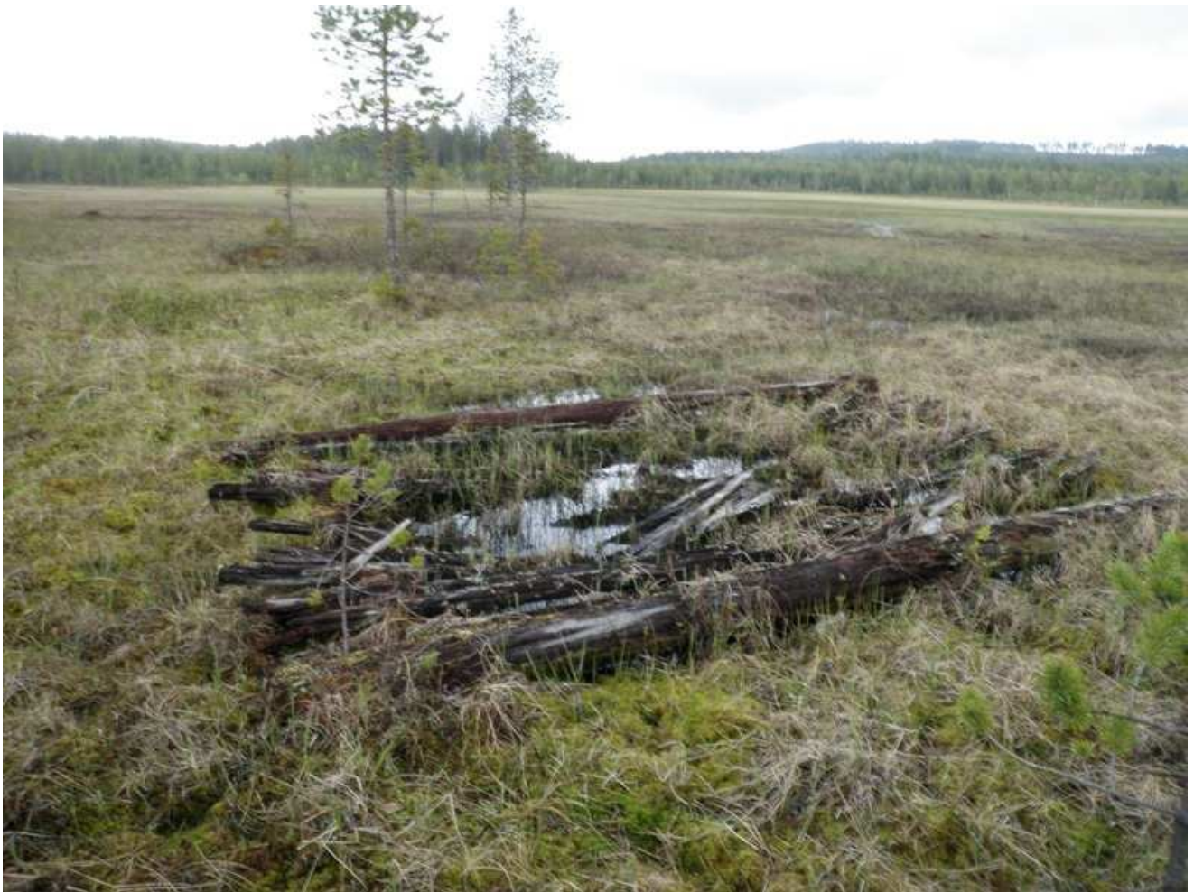
Ladon pohja on vielä suossa. Luultavasti muut rakenteet on purettu.
