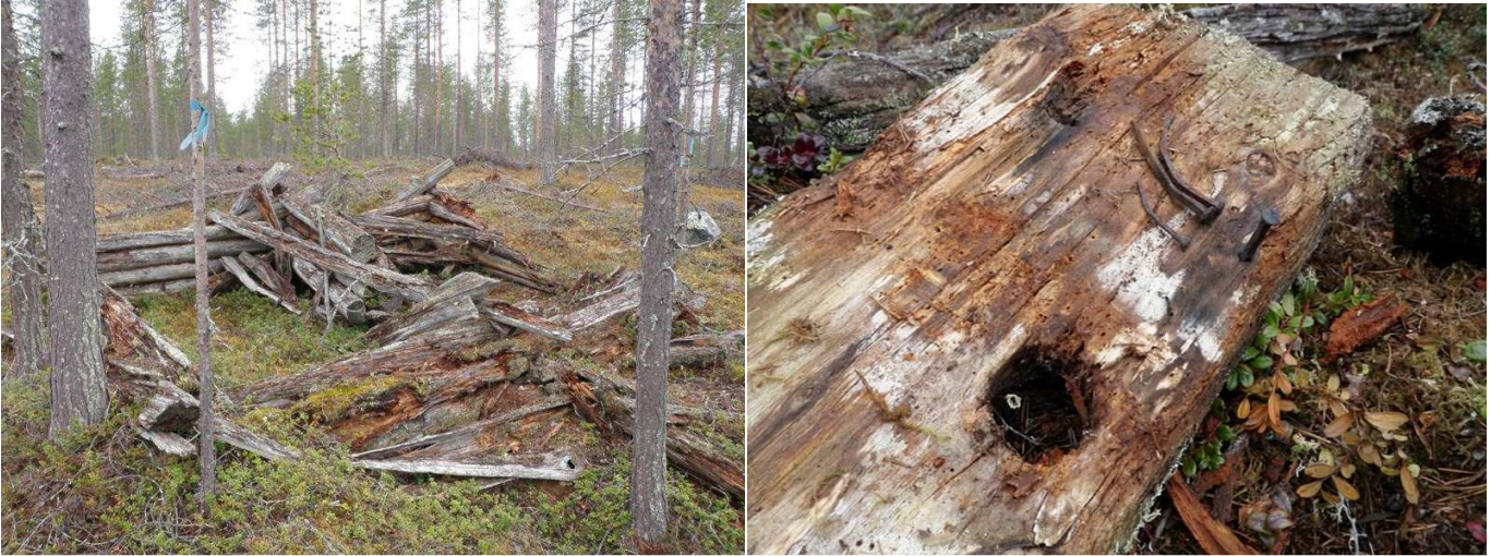
Kämpän hirsirakenteita ja sepän tekemiä nauvoja.
