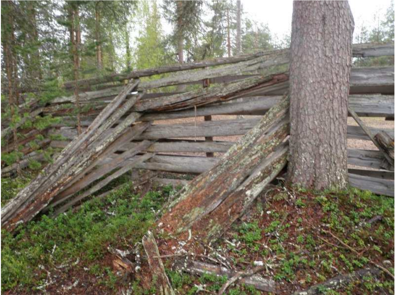
Poroaidan erotussiula on ulkoapäin tuettu.
