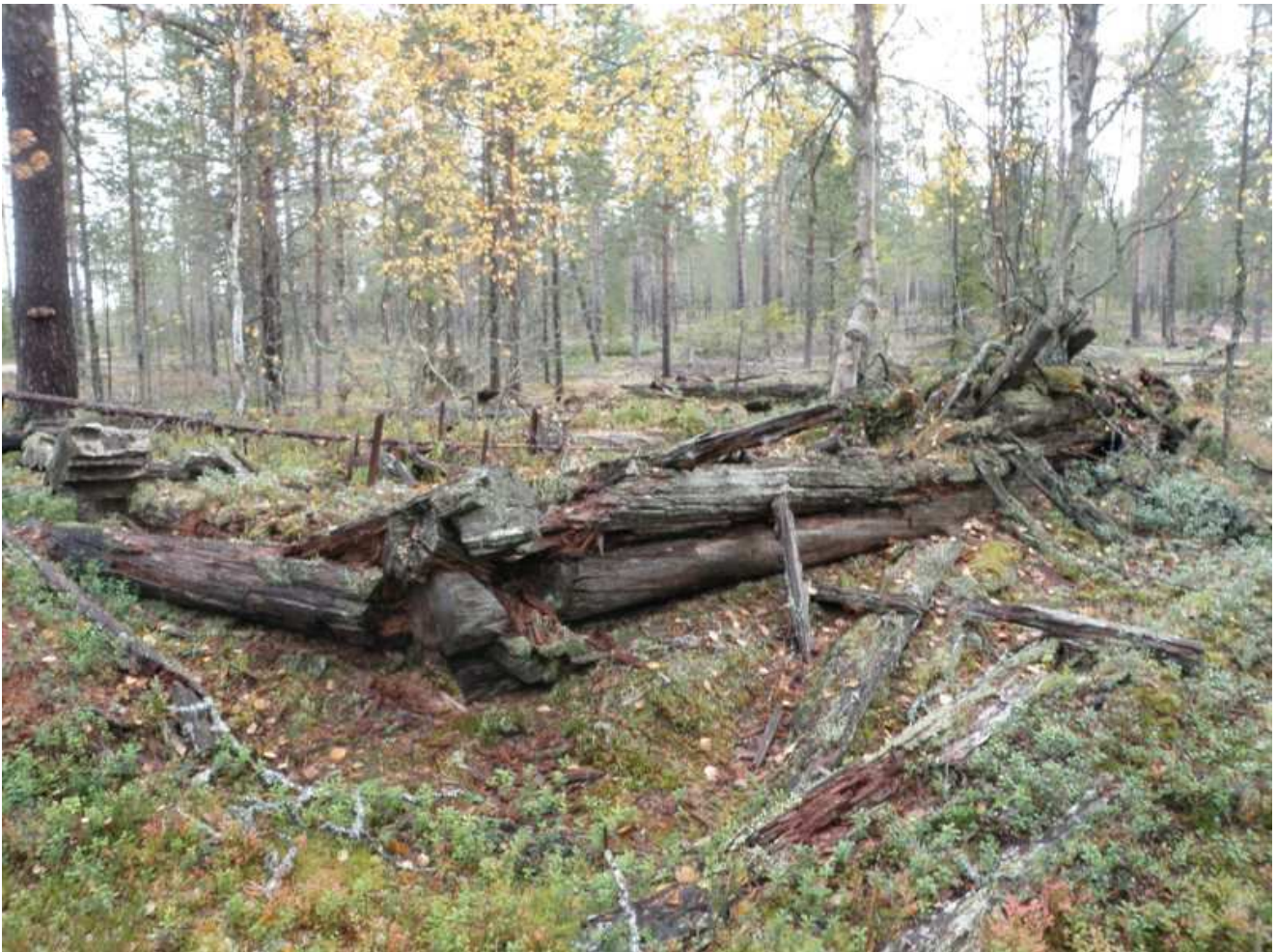
Kämpän hirsirakenteen jäännöksiä.
