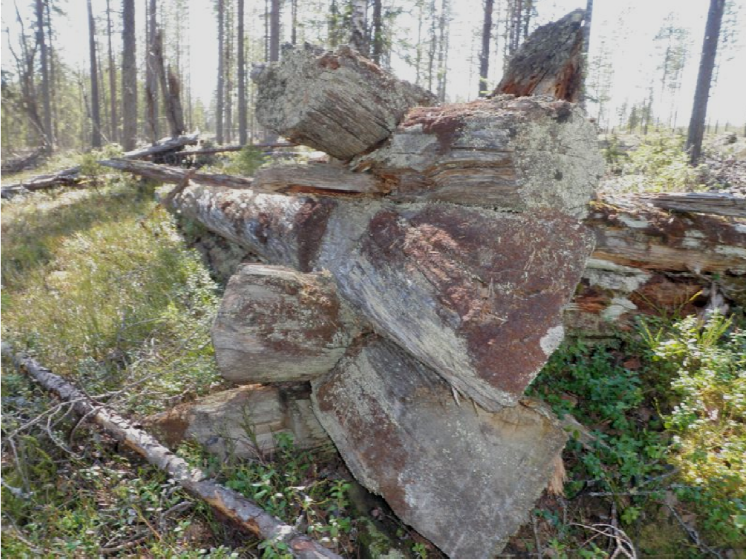
Kämpän kirveellä veistettyjä nurkkasalvoksia.
