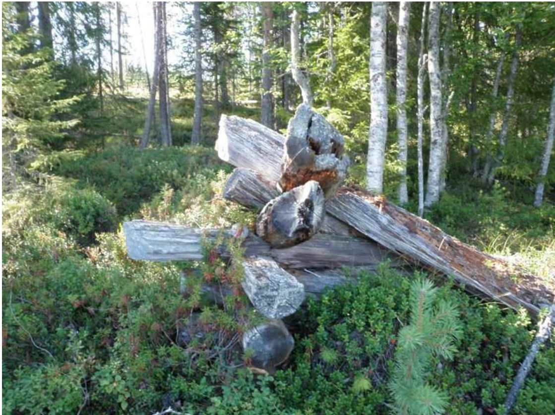
Hirret ovat sahalla ja kirveellä katkottuja.
