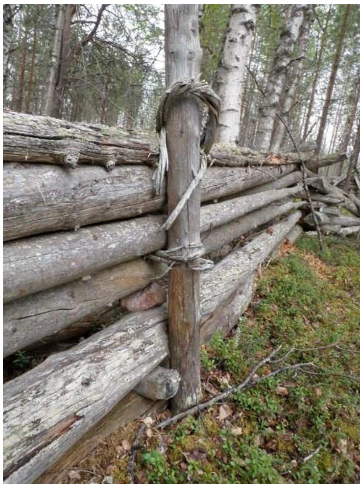
Poroaita on sidottu vitsaksilla ja pitkittäispuiden välissä on tukena kiviä.
