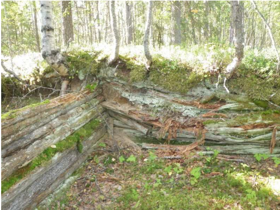
Rakennus on ollut puoliksi maahan kaivettu korsu, jonka seinät on tuettu puurakentein.
