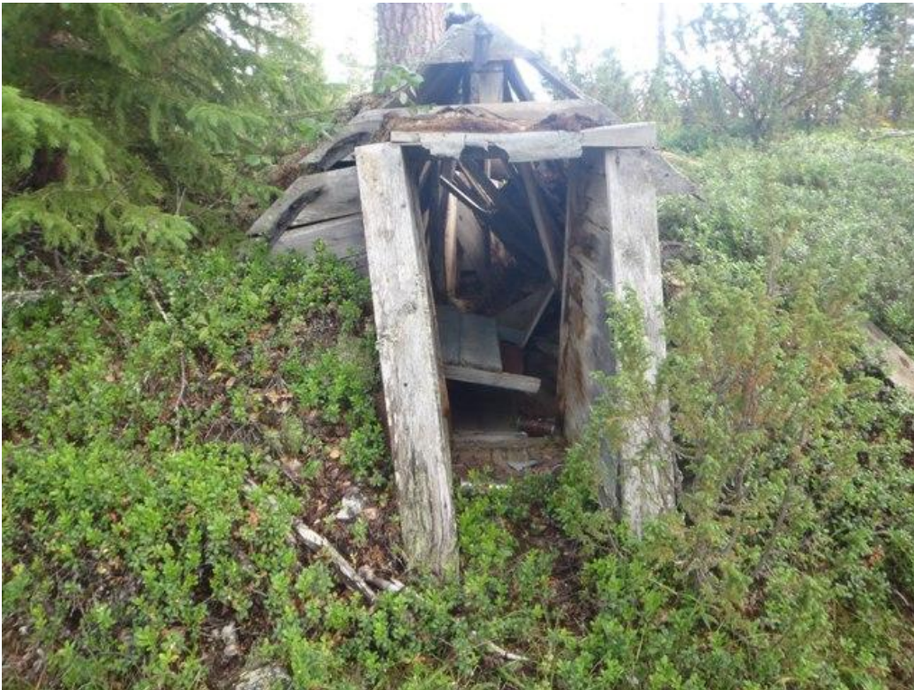
Maakellari törmän reunassa, kuvattu koilliseen.
