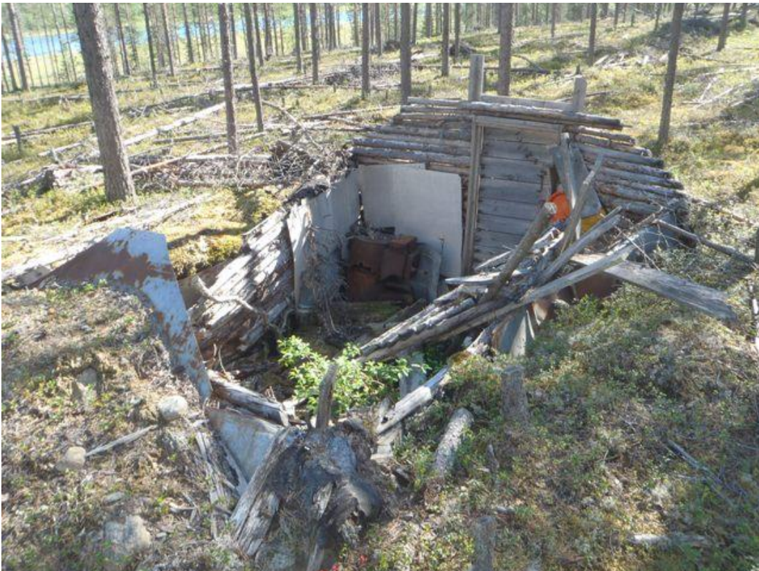
Osin maahan kaivetun kämpän seinät on tehty pienistä puista, kuvattu koilliseen.
