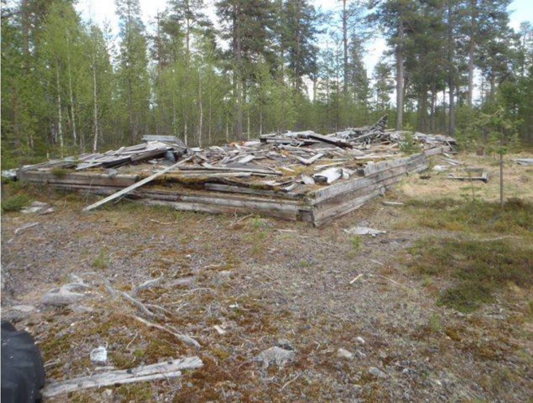
Yleiskuva kämpästä, kuvaussuunta koilliseen.
