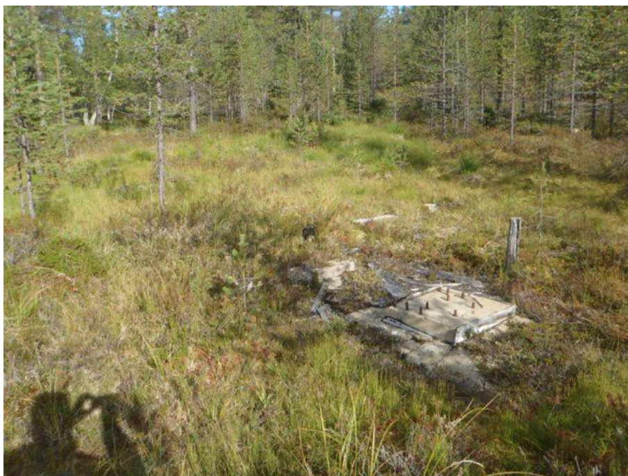
Maston betonijalka, kuvattu luoteeseen.
