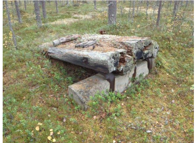
Maston tukirakenne, kuvattu länteen.
