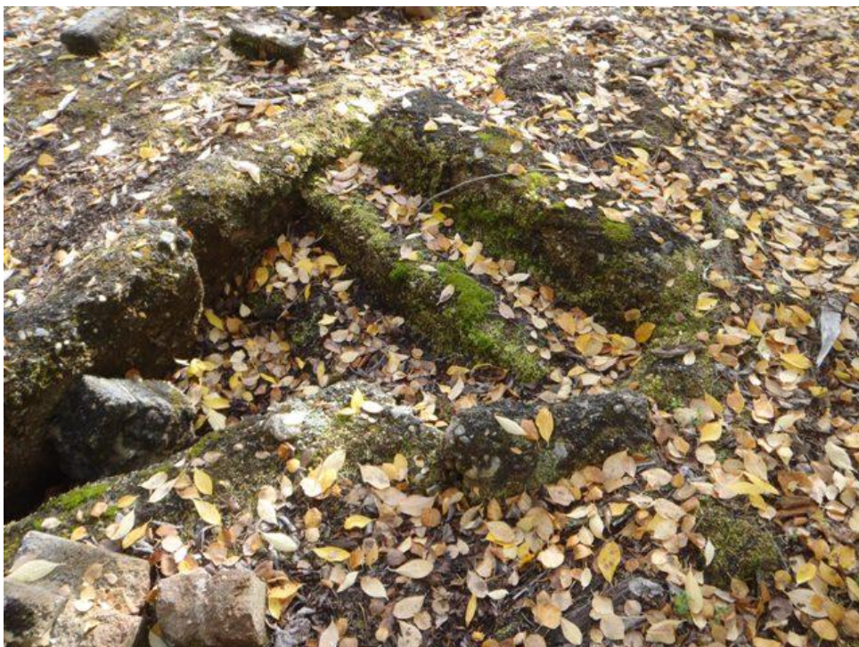
Portaat rasvamontun päässä, kuvattu kaakkoon.
