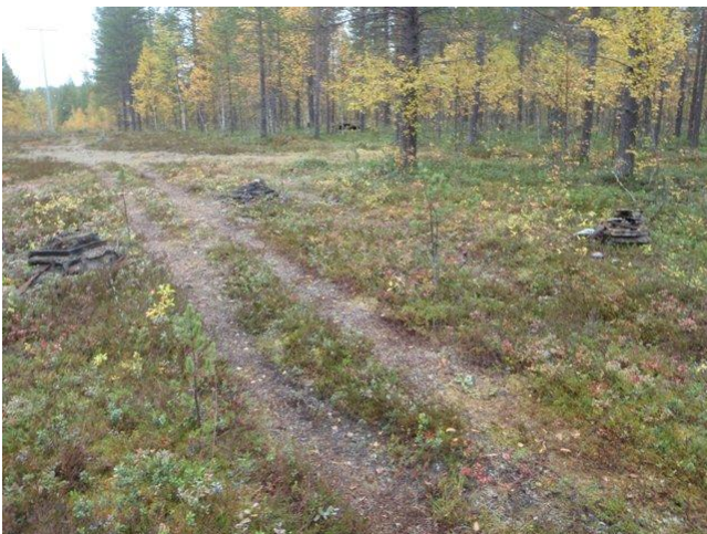
Maston betonijalat, taustalla toinen tukirakenne, kuvattu koilliseen.
