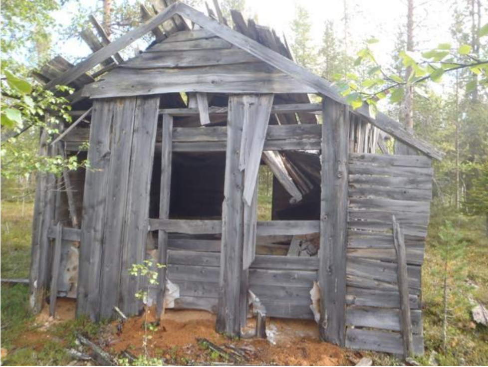
Lautarakenteinen Aikoiden kämpä, kuvattu koilliseen.
