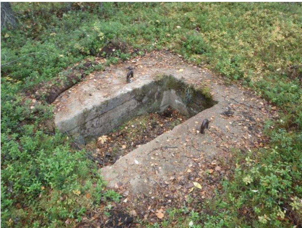
Betonirakenne kuvattuna kaakkoon.
