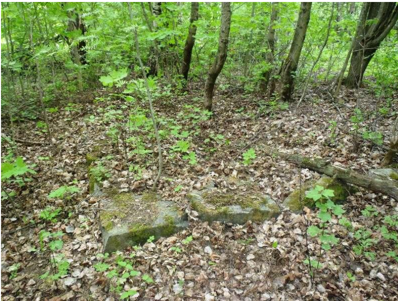
Kuva 9: Perustuksen jäännöksiä kohteessa Nummi historiallinen kylätontti 3. Kyseessä saattavat olla Jutilan taloon kuuluvat perustukset. Jouni Taivainen.
