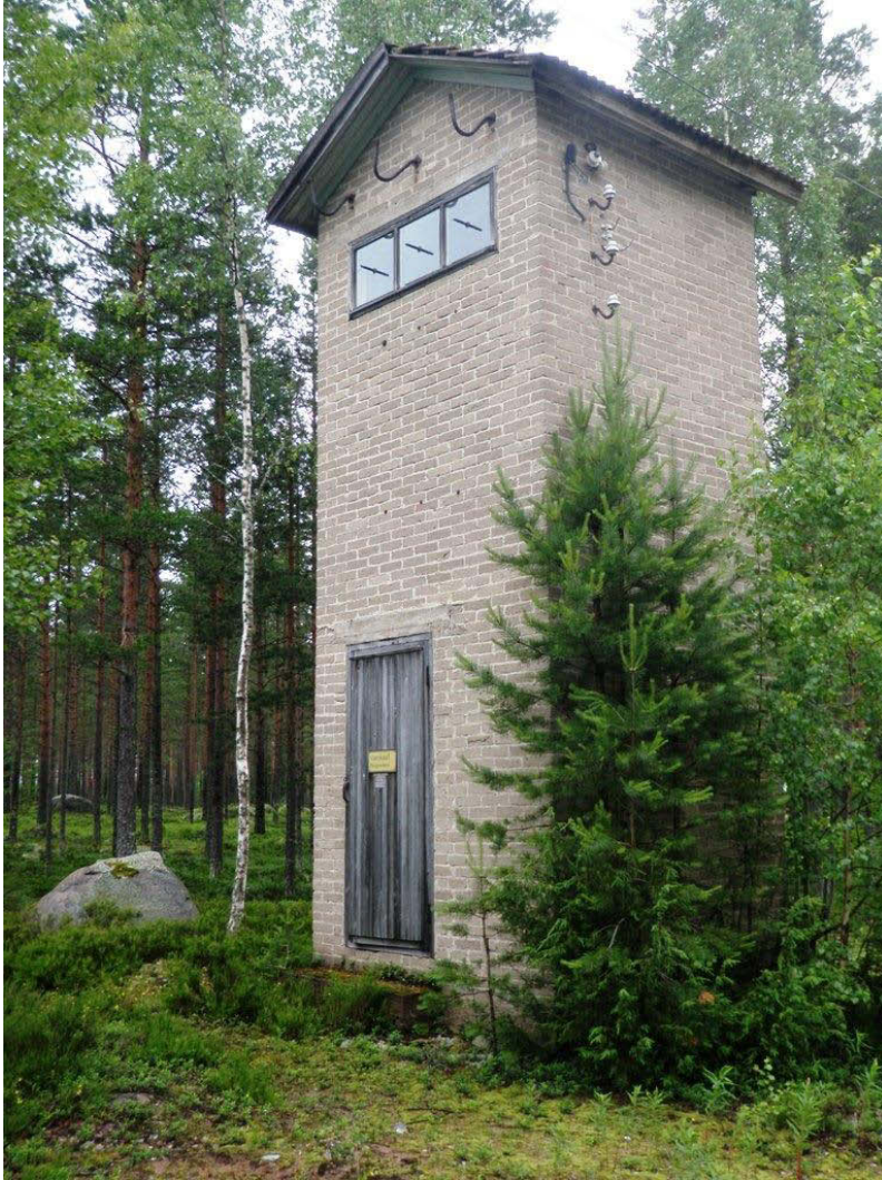
Vähäviidan muuntajatorni. Kuva P. Jantunen.
