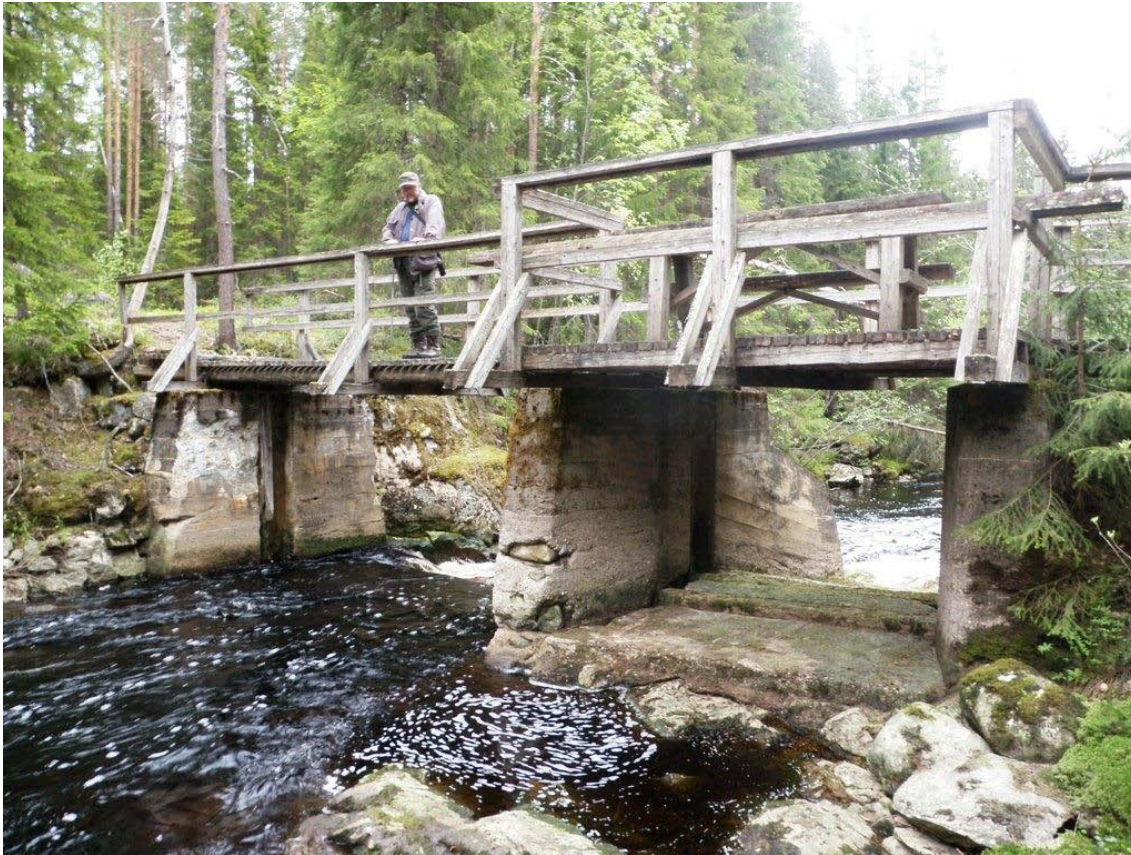
Kuva 7. Pitkäkosken betoninen pato. Sillan päällä suunnittelumetsuri Jukka Loponen. Kuva V. Laurila.
