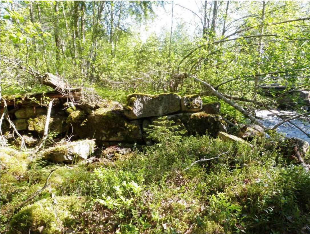
Riuttasen Myllykosken tammen rakennetta. Kuva V. Laurila.
