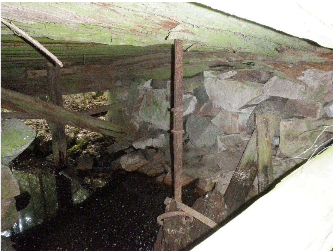
Kuvat 3 ja 4, myllyn alaosan rakenteita. Kuva 3 etelästä ja kuva 4 pohjoisesta päin kuvattuna.
