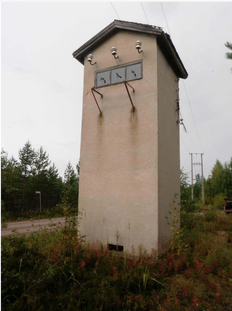
Ison Ristiharjunlammen muuntajatorni. Kuva P. Jantunen.
