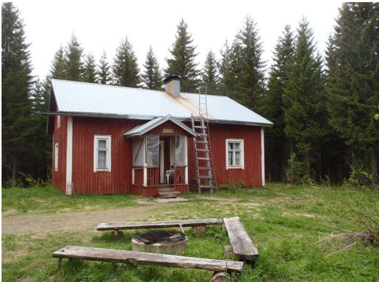
Särkimäki päärakennus 1. Kuvaaja Riku Mönkkönen.
