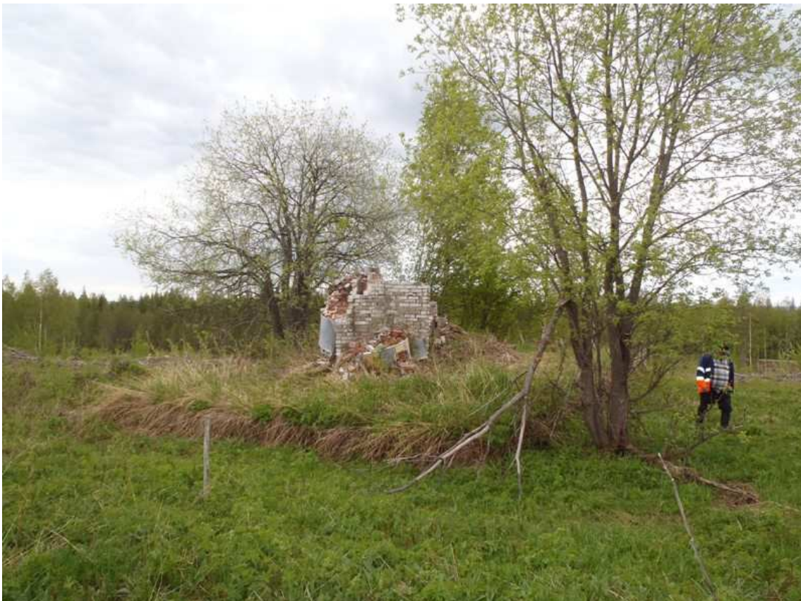
Tiitilänmäki päärakennus jäännös 1. Kuvaaja Riku Mönkkönen.
