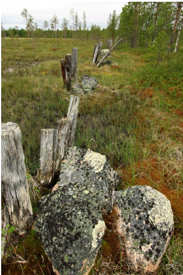
Kuva 123. Patovallin puisia ja kivisiä tukirakenteita.
