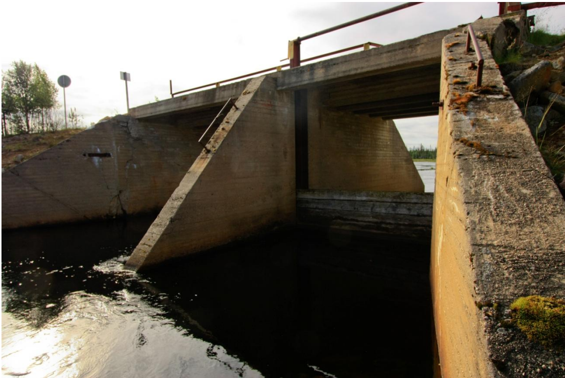
Kuva 99. Tammen betonisia rakenteita sekä puinen luukku, kuvattu luoteesta.
