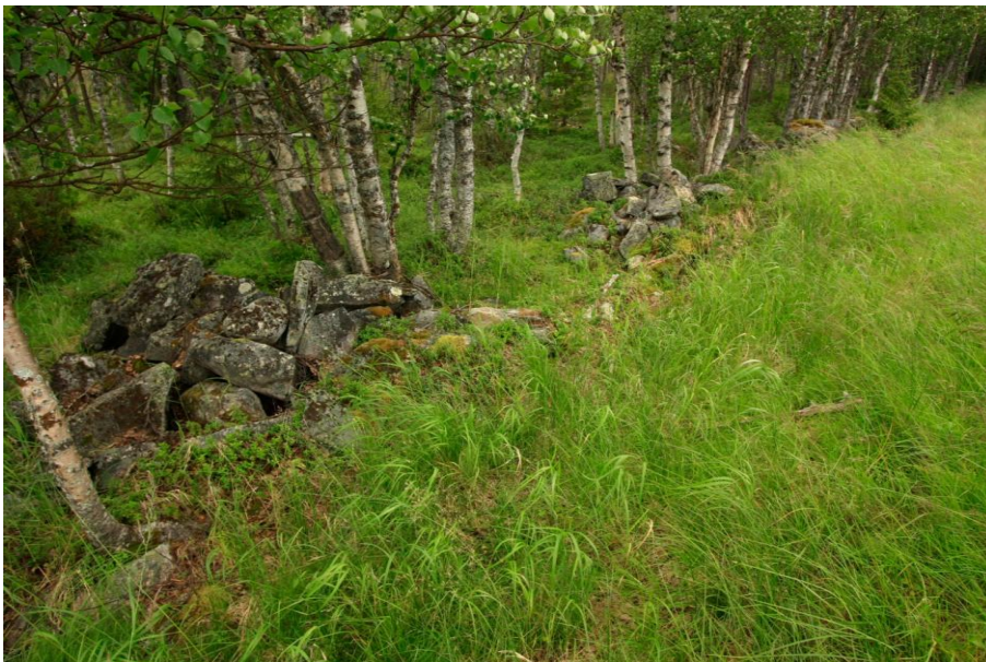
Kuva 108. Tammen patovallin kivisiä tukirakenteita.
