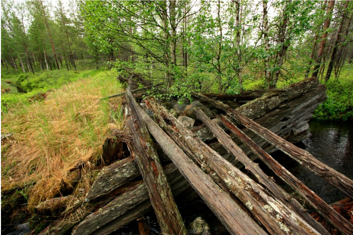
Kuva 116. Yksityiskohta padon tukirakenteista uittokanava kohdalta.
