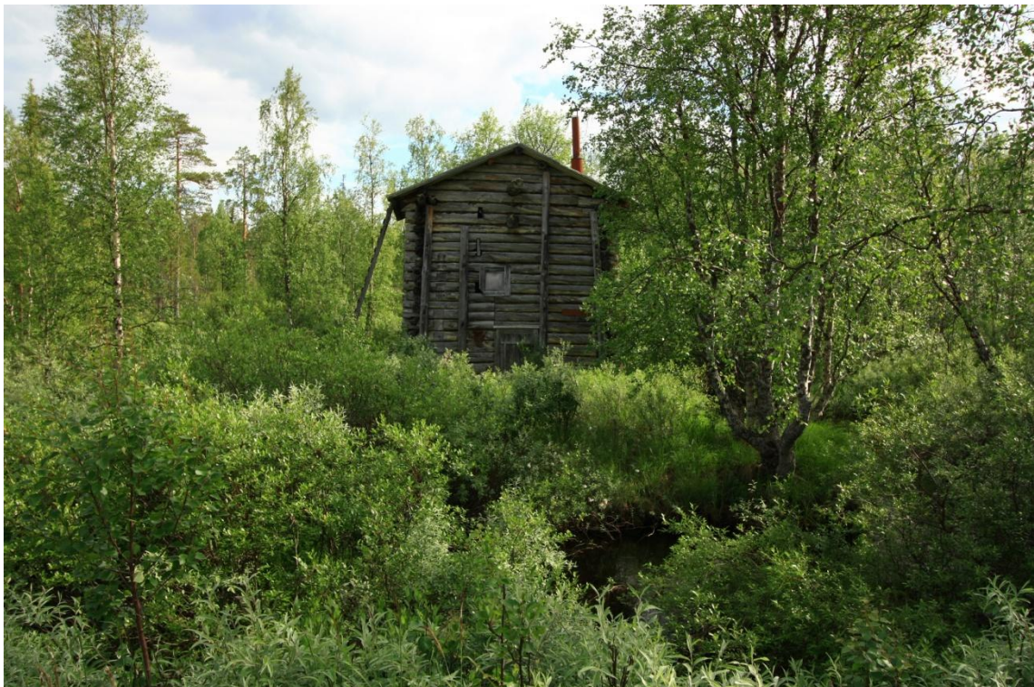
Kuva 248. Jänesojan pumppuasema keskikesällä. Kuvattu pohjoisesta.
