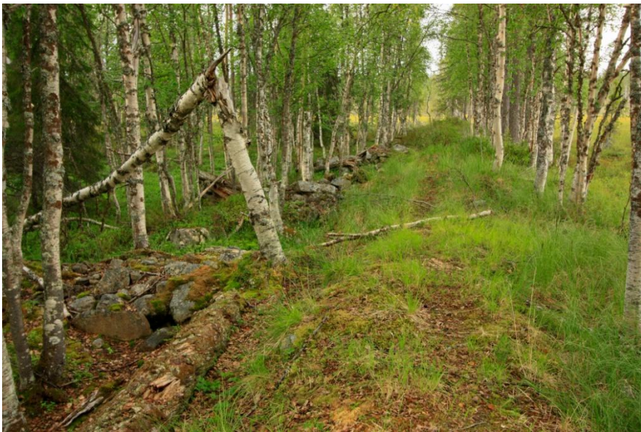
Kuva 125. Länsipuolinen patovalli ja sen tukirakenteita, kuvattu idästä.
