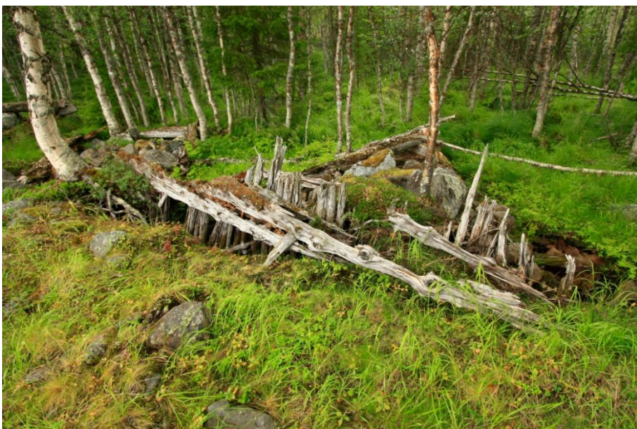
Kuva 126. Padon itäpuolen puisia tukirakenteita.
