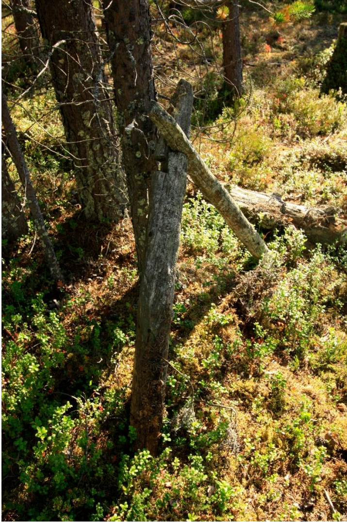
Kuva 114. Parkkuupukki, kuvassa näkyvät hyvin lovet, joihin poikkipuun lovet, joihin jalat on kiinnitetty.
