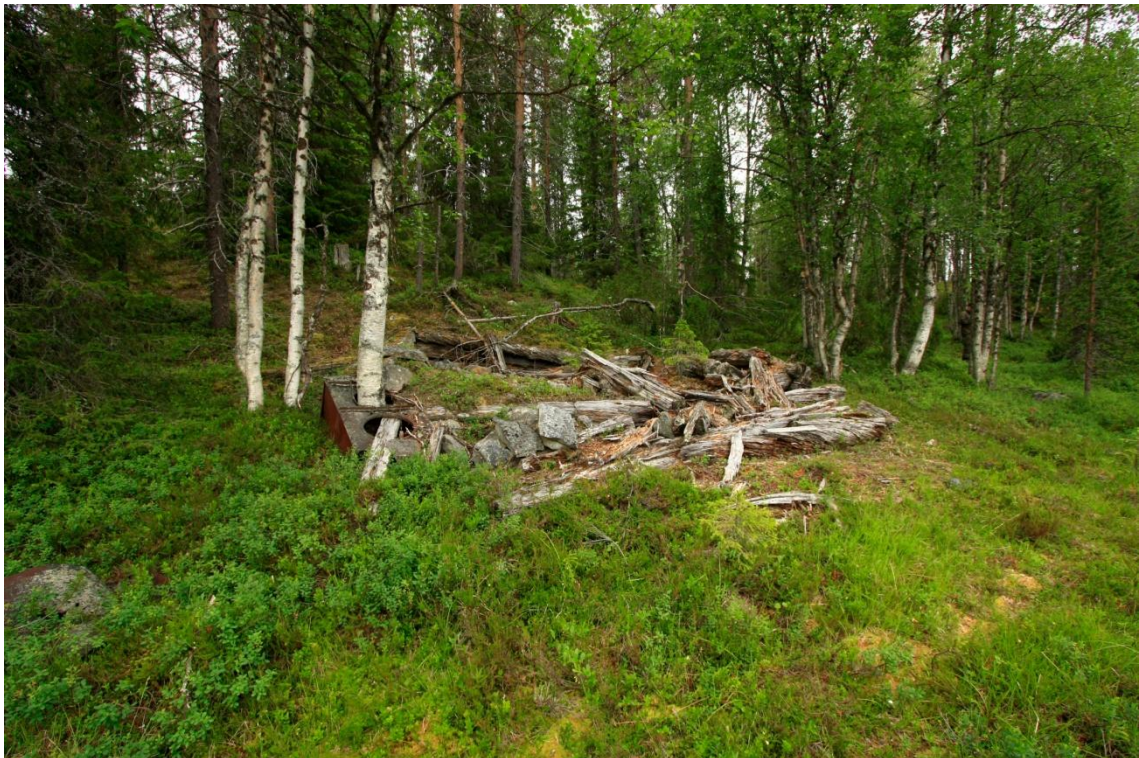
Kuva 170. Pyhäselmin kämpppä, rakennus 1. Kuvattu etelästä.
