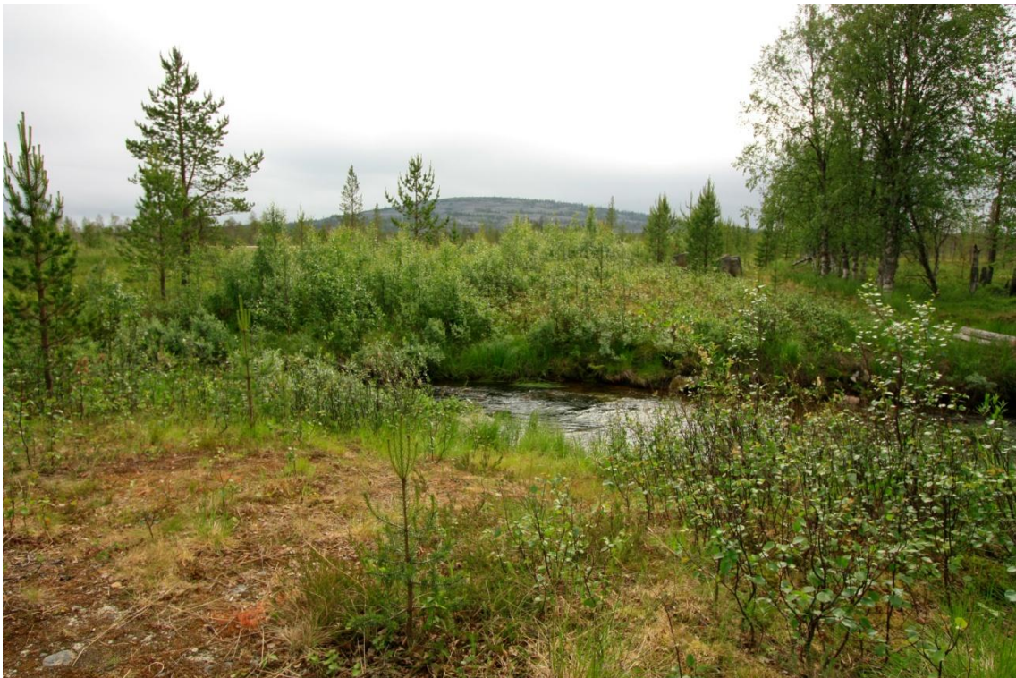
Kuva 122. Tammen päälle rakennettu tie. Patovallin tukirakenteita näkyvissä kuvan oikeassa laidassa. Taustalla kohoaa Rannimmainen Sotatunturi.
