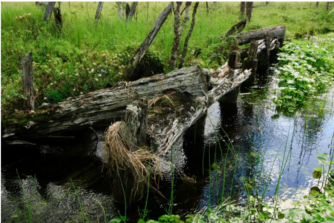
Kuva 221. Yksityiskohta Vouhtujoen sillan rakenteesta.
