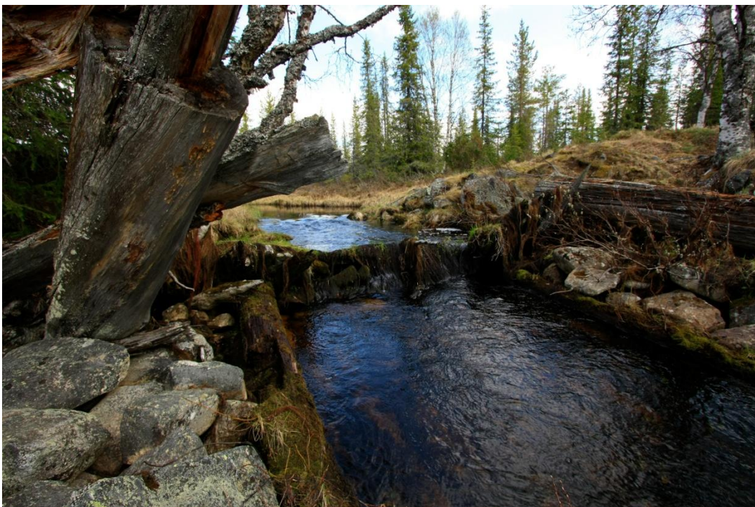
Kuva 119. Yksityiskohta tammen länsiosan uittorännistä.
