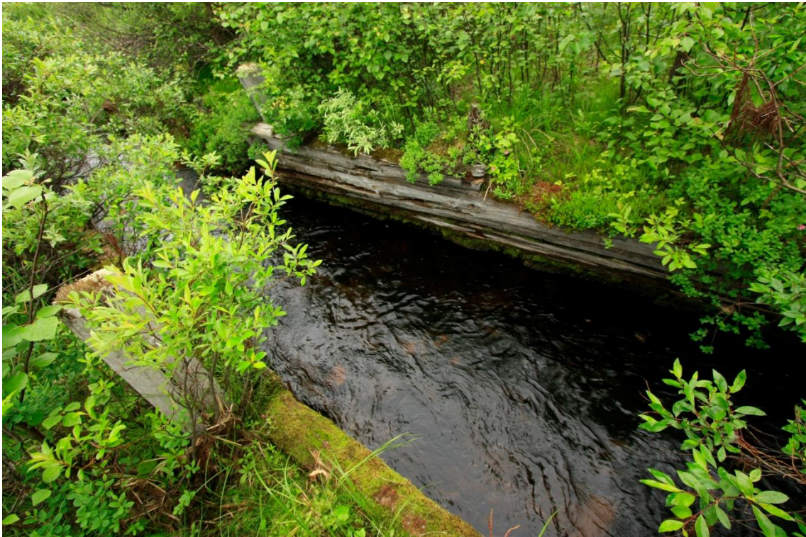
Kuva 121. Itse tammi on purettu, mutta Ruuvaajaan on jätetty tukkien uittoränni.
