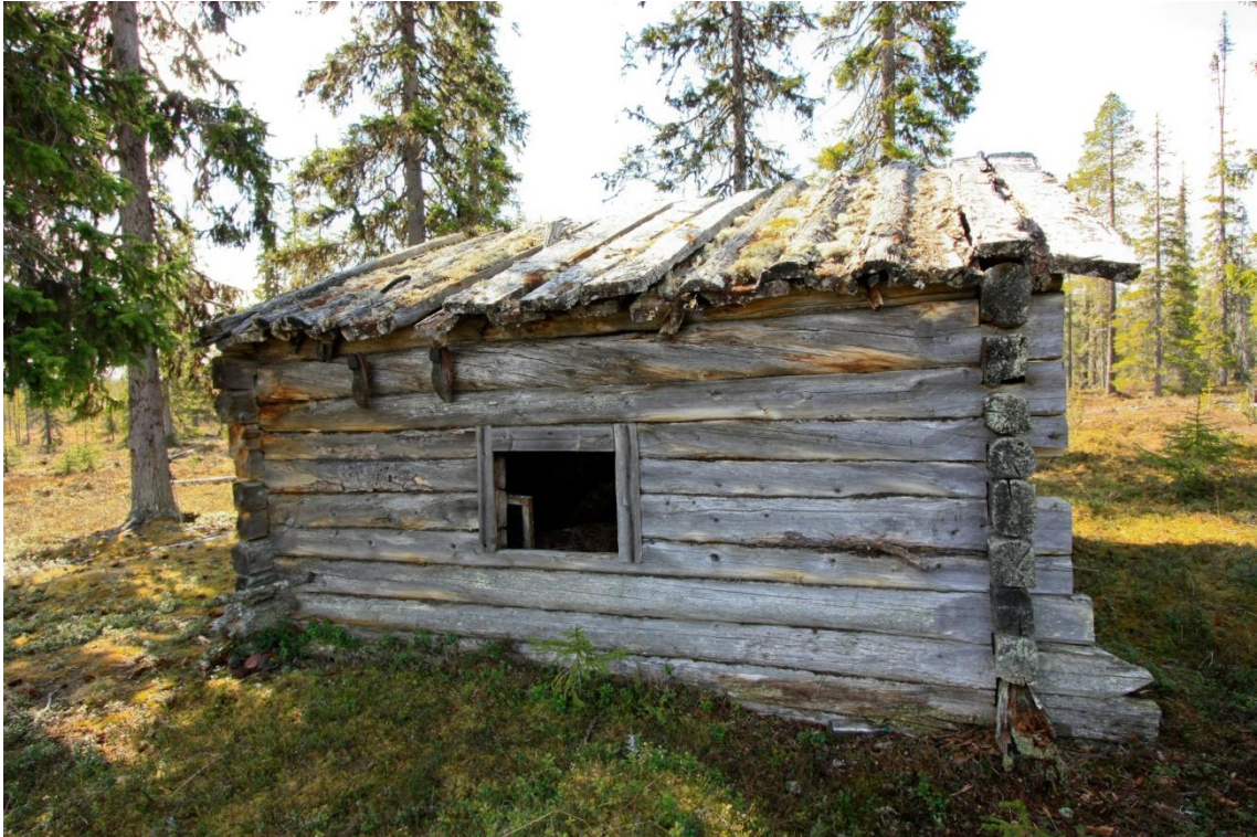
Kuva 147. Pottukämpän ikkunallinen itäseinä, kuvattu idästä.
