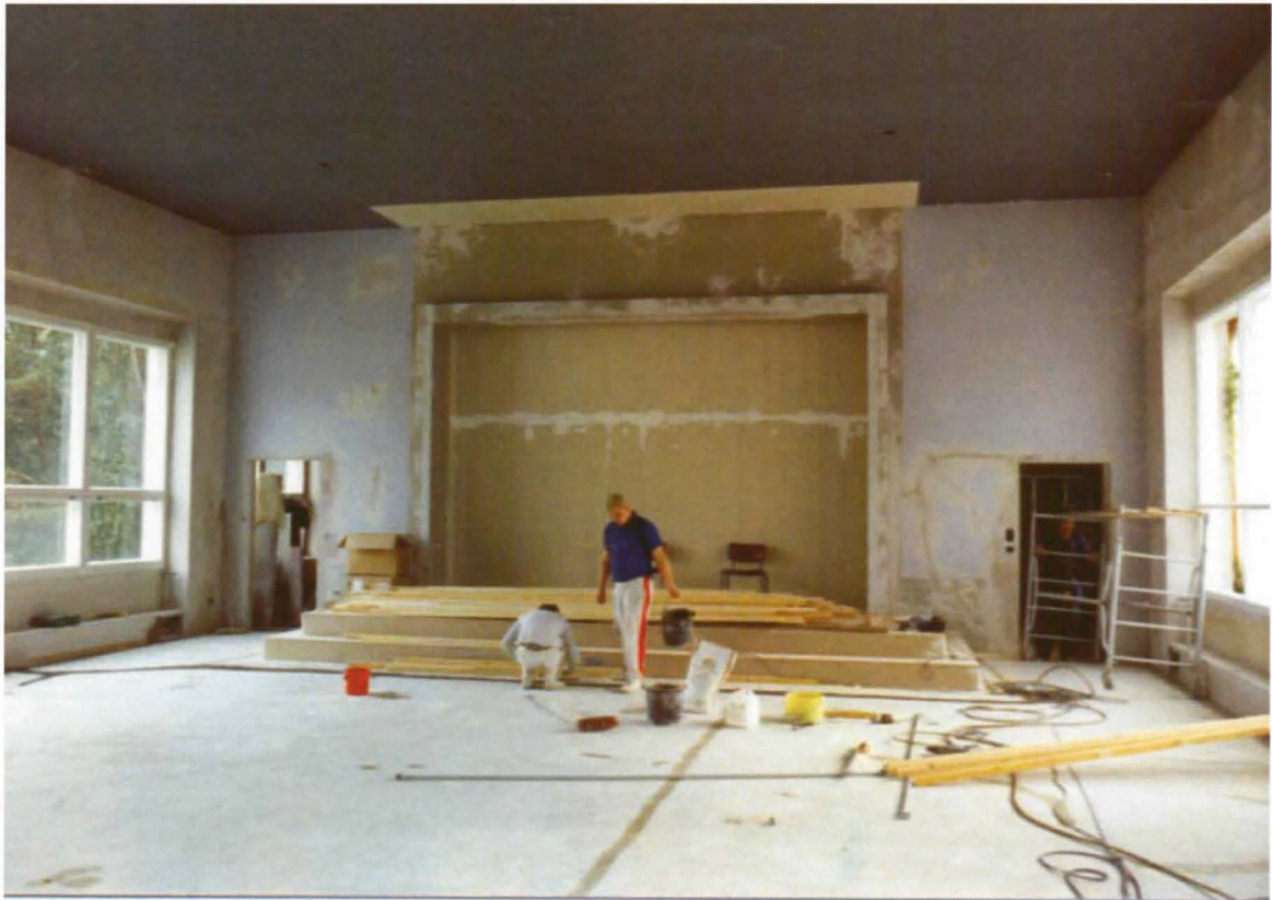
Kuva juhlasalin muutostöistä v. 1988. Kuva Hyvinkään sairaalan arkisto.
