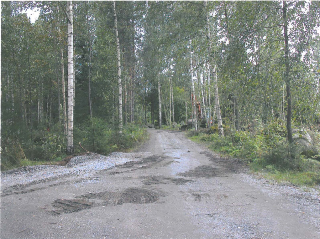
Valvonta 29.8.2005. Karholannokantietä Metsärinteen tilan kohdalla, kuvattu itään. Viemäri linja on tarkoitus kaivaa tien yli kuvan taka-alalla olevassa osassa.
