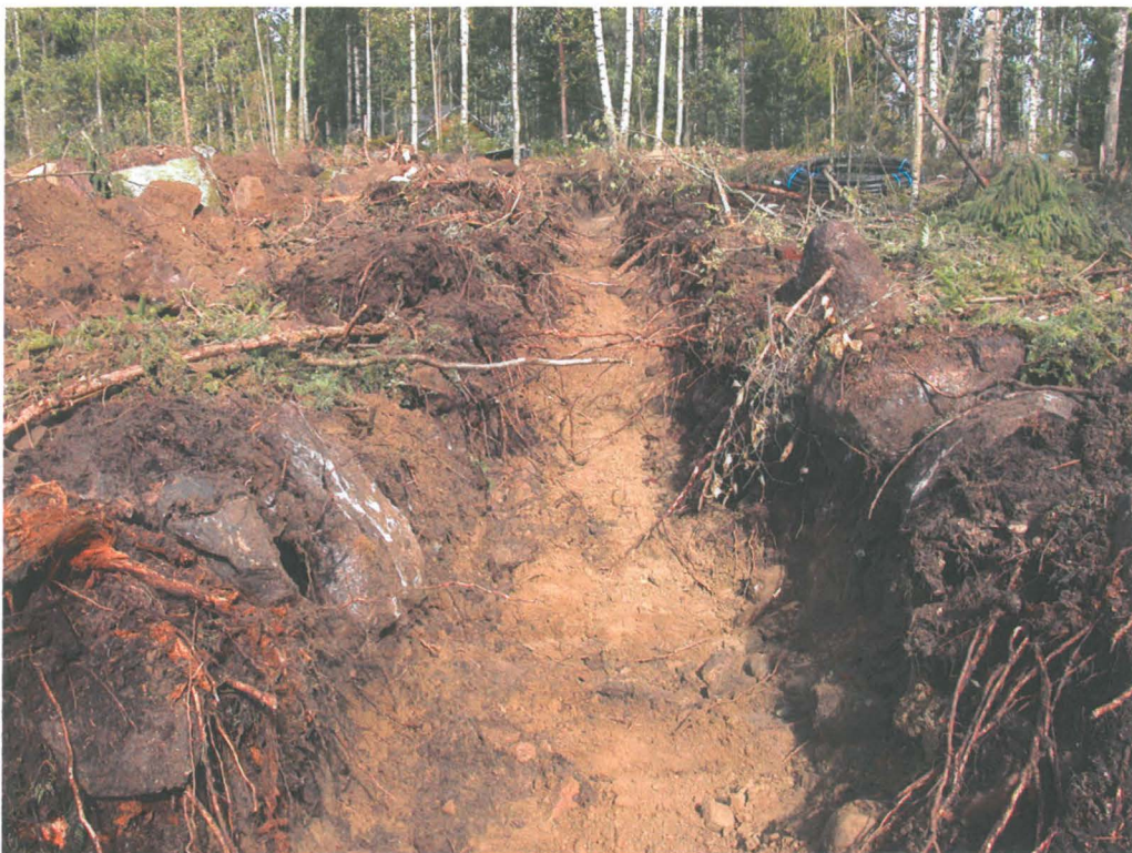
Vesilahti, Narva, Karholannokka, 29.8.2005 valvonta. Esille kaivettu viemäri linja, kuvattu pohjoiseen.
