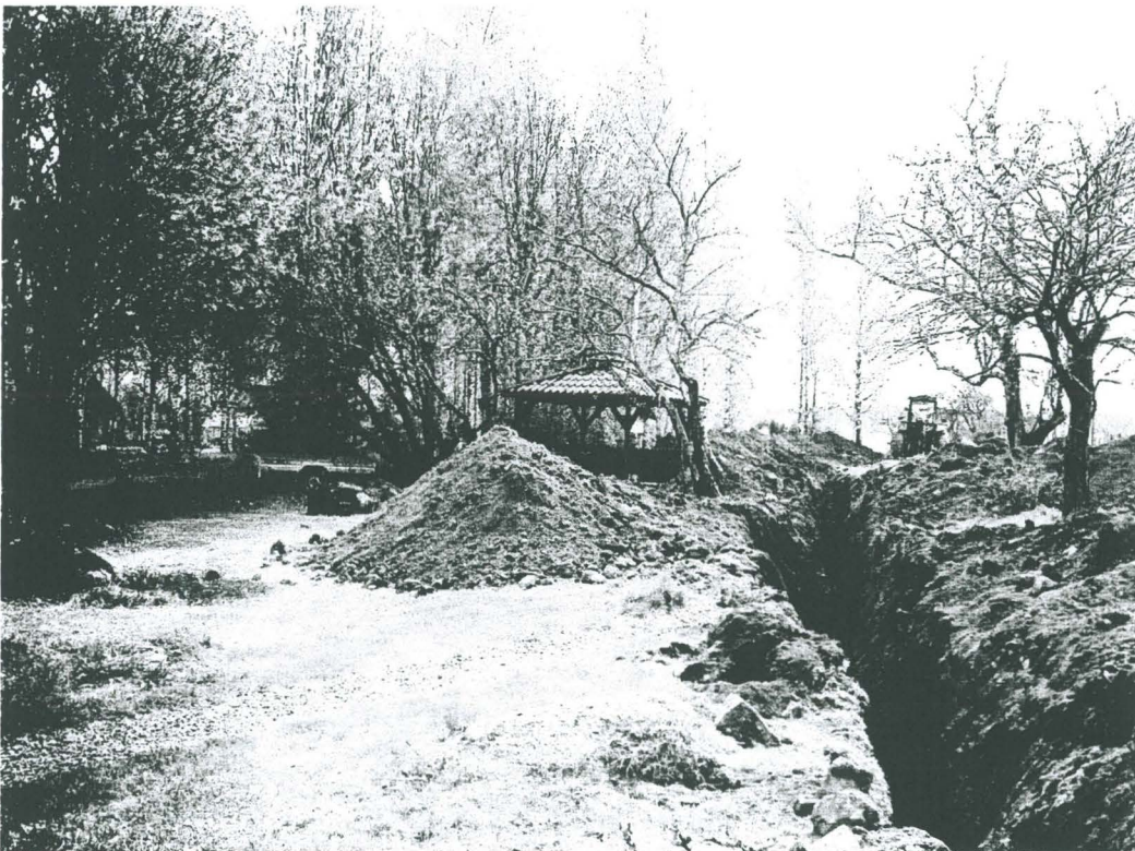
Lähes valmis vesijohtokaivanto enne täyttämistä. Kuvattu pohjoisesta.
