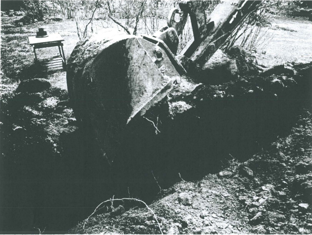
Lähikuva kaivannosta Kivirannan asuinrakennuksesta n. 20 m etelään.
