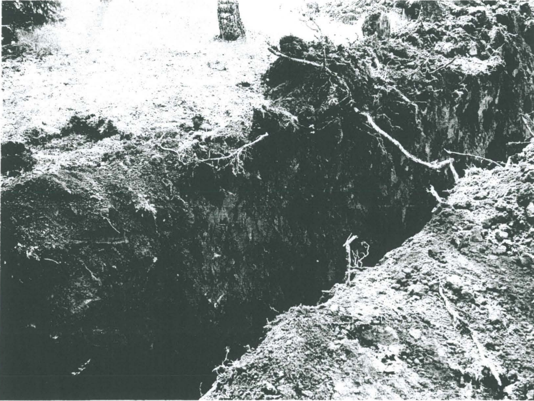
Lähikuva Saunarannan tilalla kaivetusta linjasta, etäisyys rakennukseen n. 15 m. Kuvattu kaakosta.
