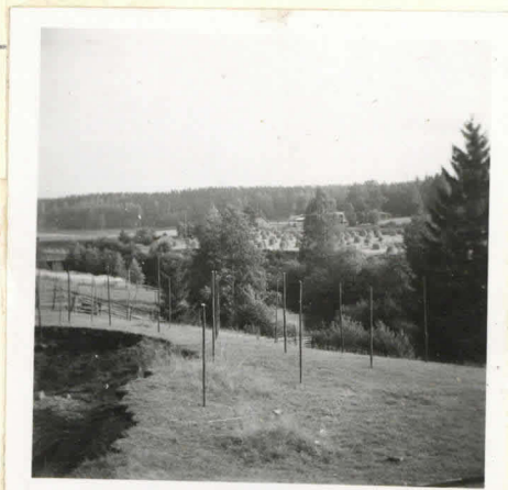
9. F. 17.821. Kaivausalue paalutettuna. Kuvattu etelästä.
