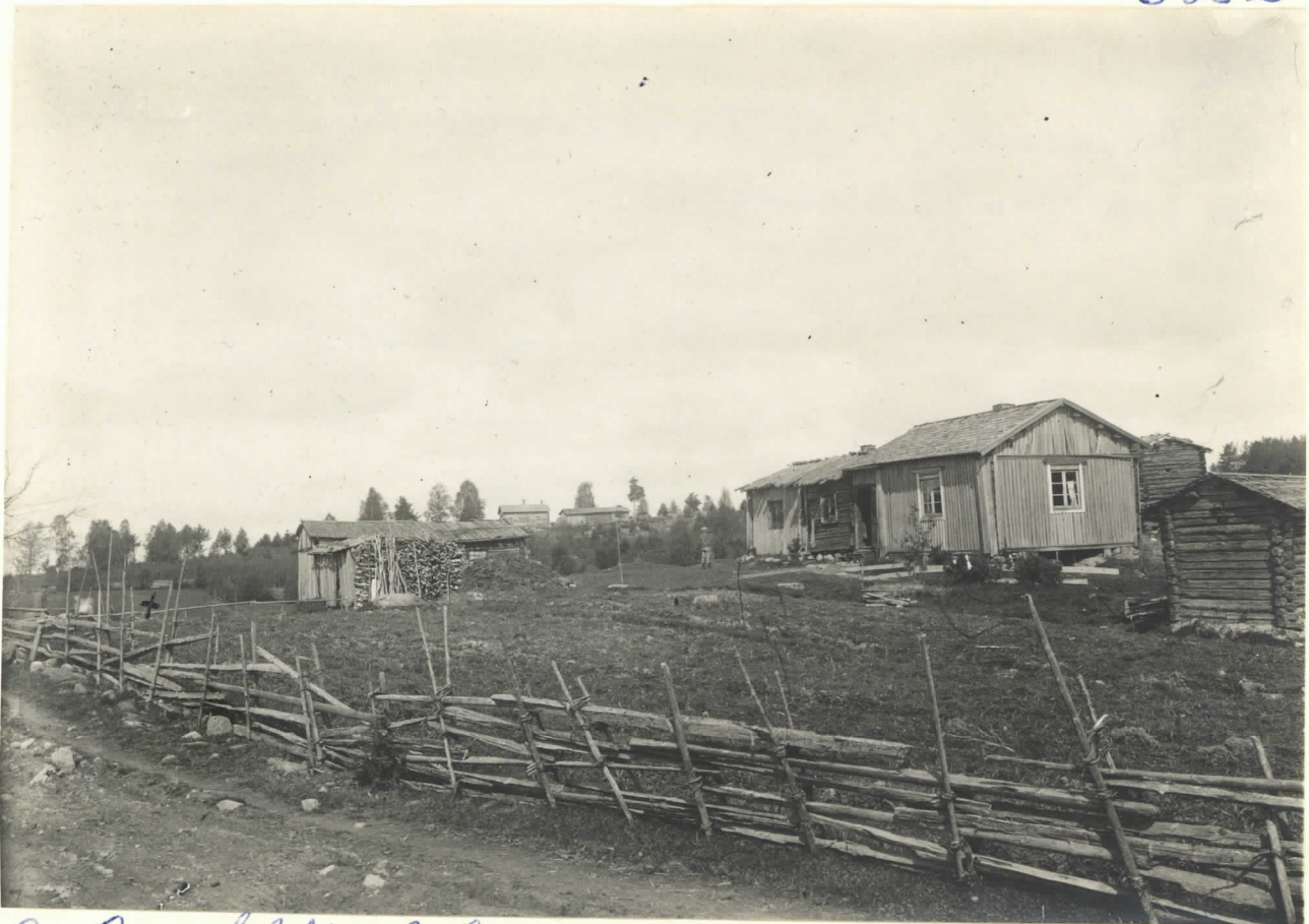
2. Gröndahlin työalue. Kaivausalue I merkitty ristillä.
