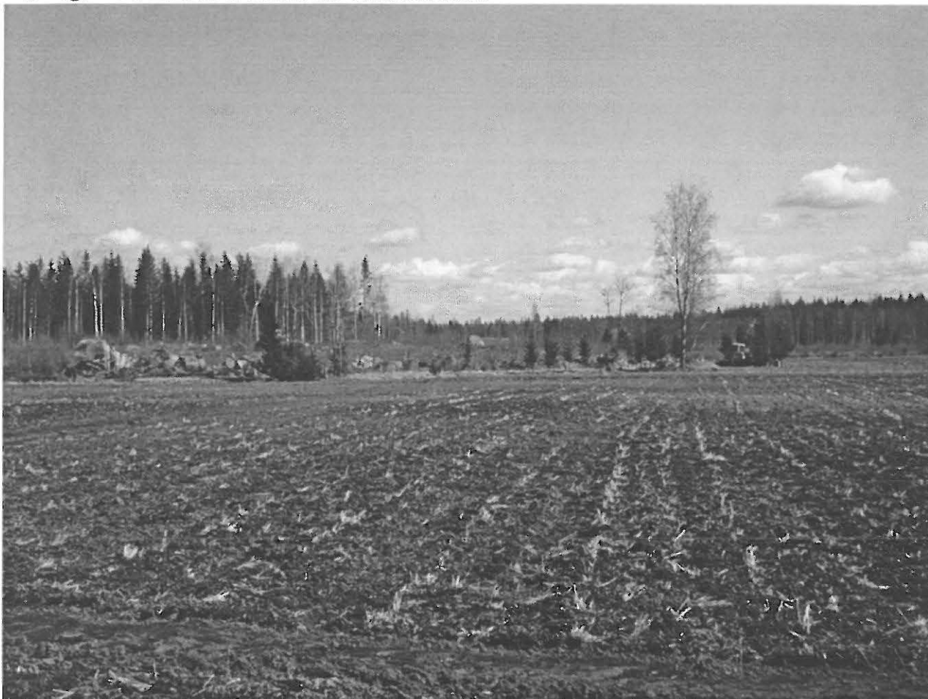
Rakennuspaikka (kaivinkone) kuvattuna Höysälänlakialta koilliseen. Kuvan vasemmassa reunassa näkyy tuhoutunut lato sekä nosteltuja kiviä. Pellon reunassa kulkee harmaa tien kiviperusta.
