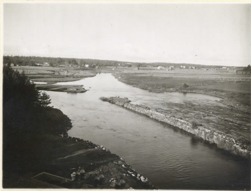
Kuva 1. Näköala Kvarnabba 10214 (Björkforsin Sähkölaitoksen katolta) länteen, Ahtavänjoen laaksoa alaspäin ja Neder-Lappforsin Kylään. Valok. 10. 9. 1935.
